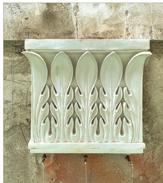
Установка капителей пилястр после расчистки на северном фасаде. Разметка для последующего устройства фуста. Фото 2020 года
