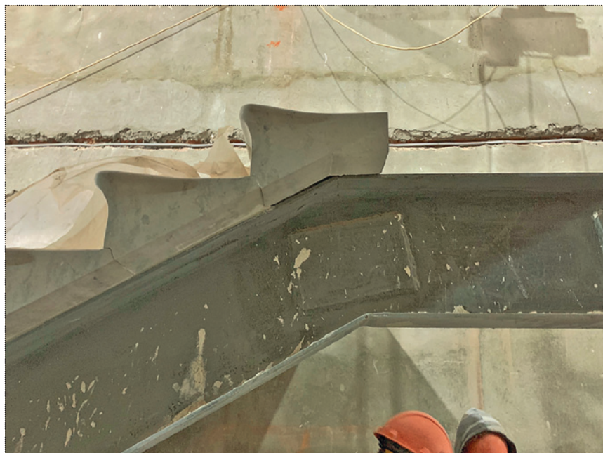
Установка воссозданных ступеней северной лестницы. Фото 2020 года
