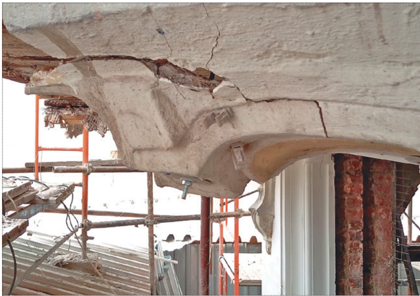
Поддерживающая эркерной консоль. Фото 2018 года
