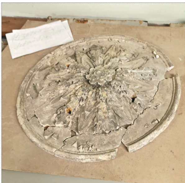
Процесс сборки разрозненных фрагментов для реставрации элемента. Фото 2019 года
