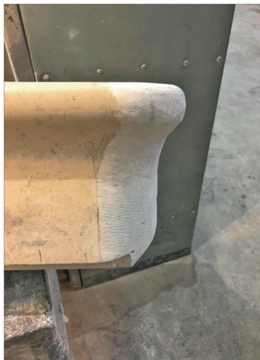
Изготовление новых ступеней северной лестницы. Фото 2020 года
