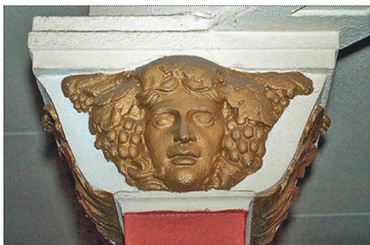
Колонны балкона до начала реставрационных работ. Фото 2017 года
