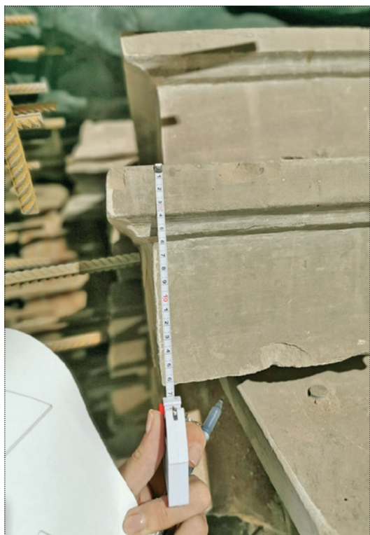
Снятие профилей с сохранившихся ступеней юго-восточной лестницы. Фото 2019 года
