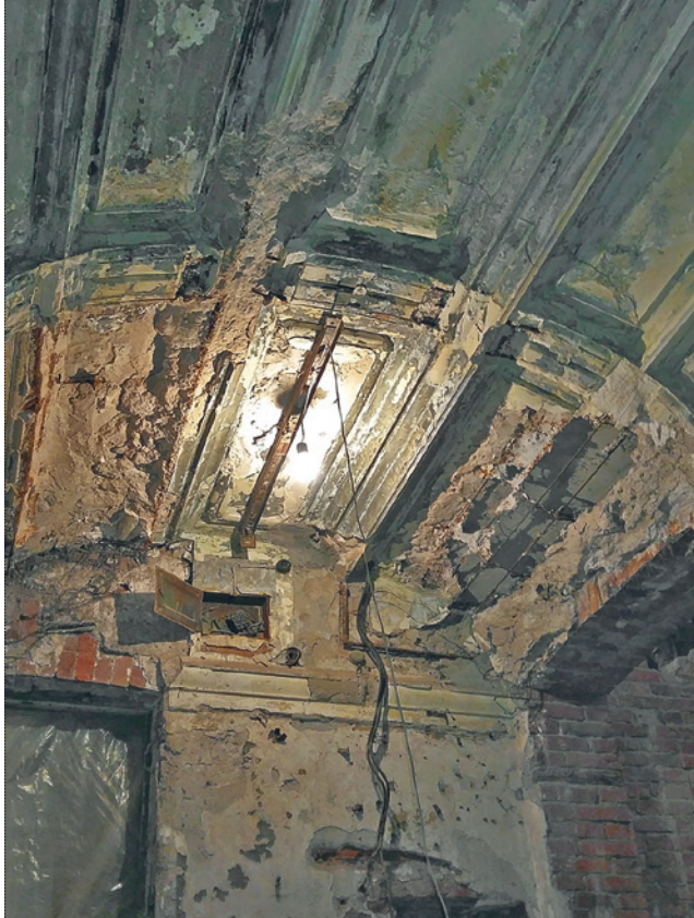
Свод лестничной клетки по улице Ю. Фучика. Фото 2016 года
