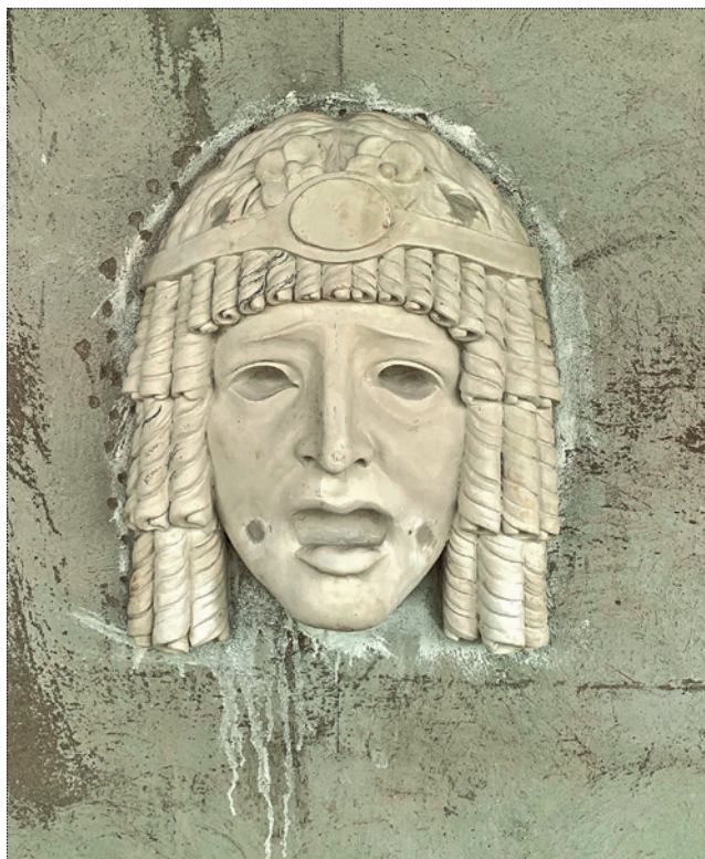
Женский маскарон западного фасада в процессе установки. Фото 2020 года
