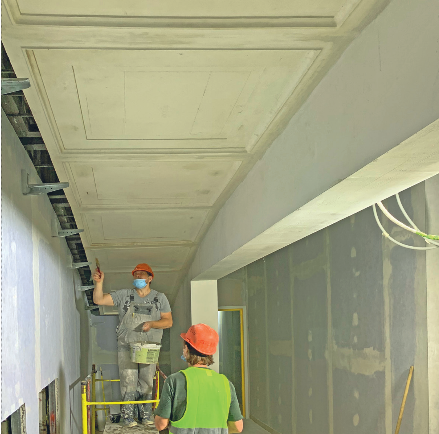
Исторические кассоны, установленные на свое место в кинооператорской. Фото 2020 года
