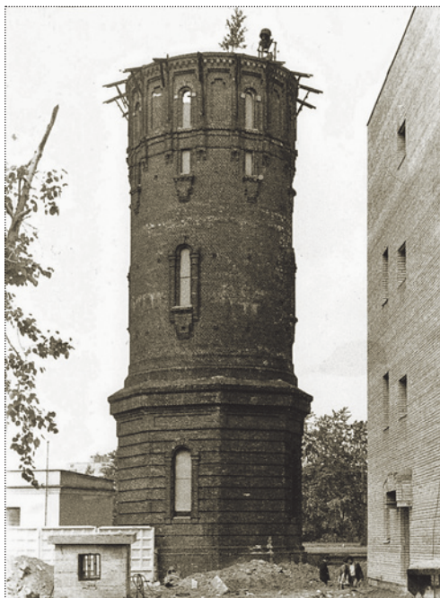
Водонапорная башня у станции Лосиноостровская – памятник московской промышленной архитектуры рубежа XIX–XX веков. Находится в Ярославском районе на северо-востоке Москвы, адрес – Хибинский проезд, 5. Была построена в 1898–1901 годах. Фото 1986 года
