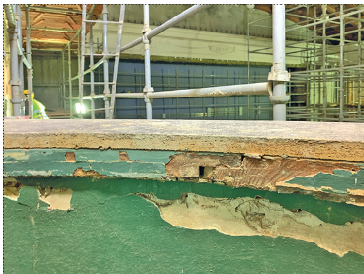
Поручень ограждения боковой ложки до начала удаления поздних отделочных наслоений. Фото 2020 года
