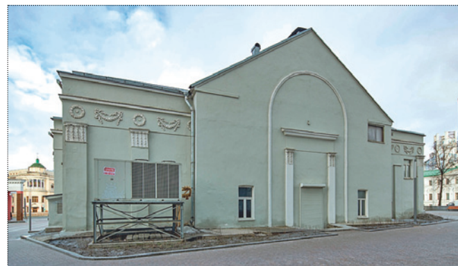
Восточный фасад здания. Фото 2018 года
