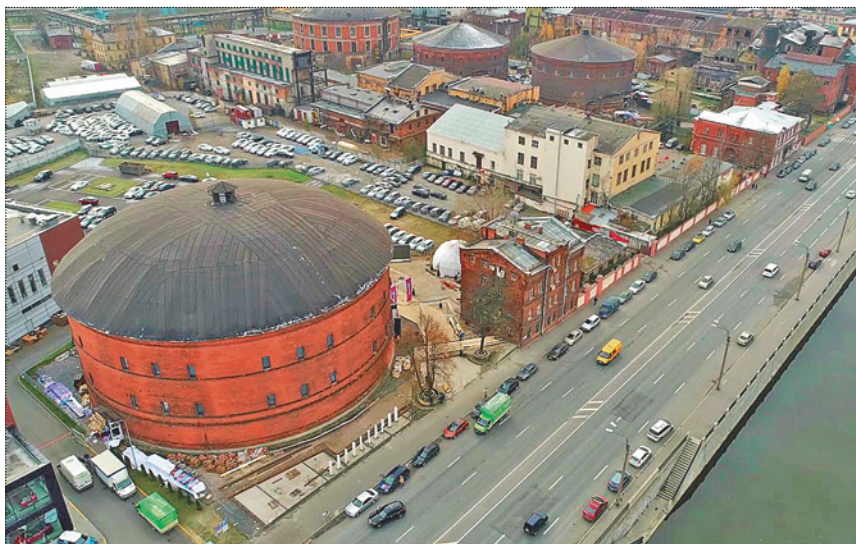
Вид с высоты птичьего полёта на газгольдеры бывшего газового завода. Фото 2019 года (en.panevin.ru)
