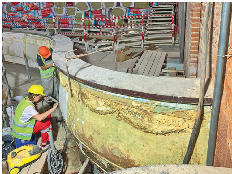
Процесс снятия красочных слоев с поля балкона. Фото 2020 года
