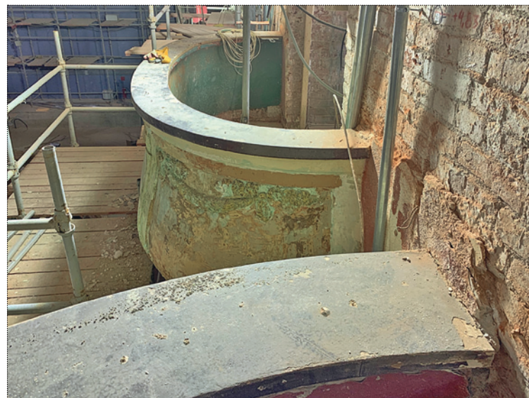
Расчищенный от красочных слоев декор балкона. Фото 2020 года
