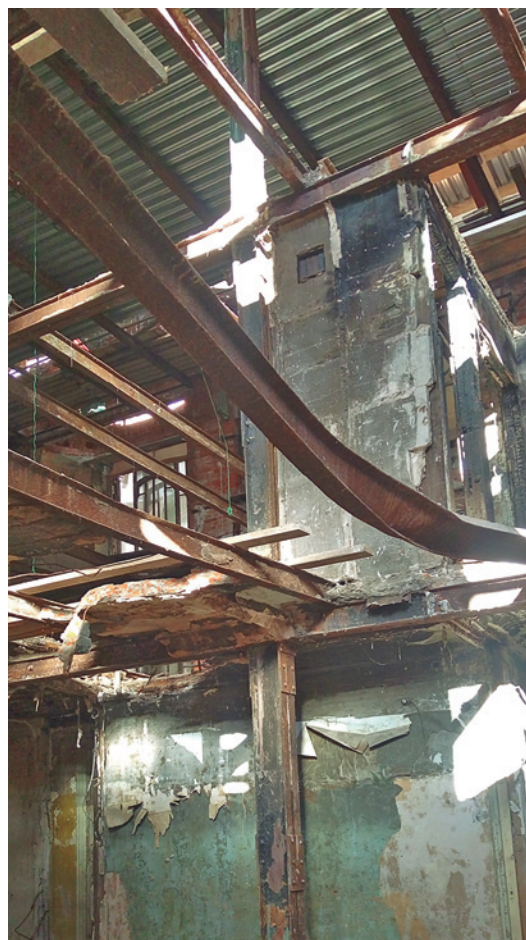
Металлические балки перекрытия. Фото 2016 года
