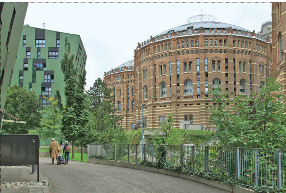
Вид на башни газометров от жилого комплекса Ville Verde. Фото автора, 2018 год
