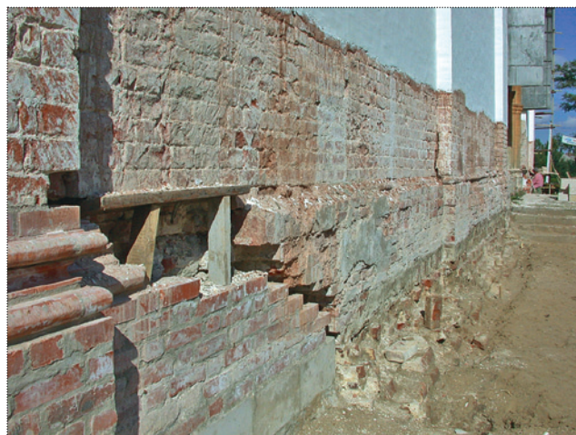
Восстановление первоначального цоколя Софийского собора в Вологде. Фото 2004 года
