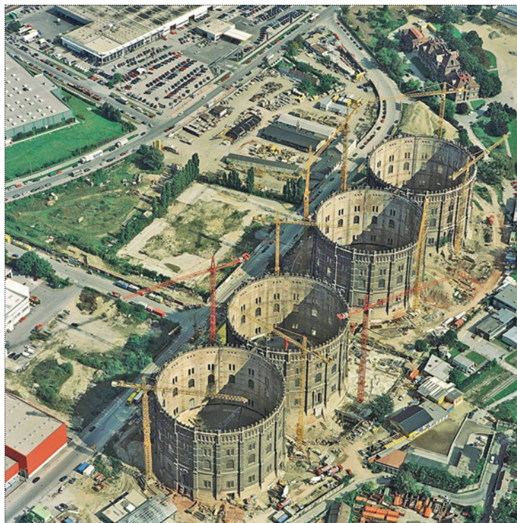
Начало реконструкции газометров в венском районе Зиммеринг. Фото конца 1990-х годов ( www.berlogos.ru )
