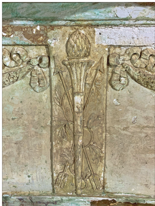
Расчищенный от красочных слоев декор балкона. Фото 2020 года
