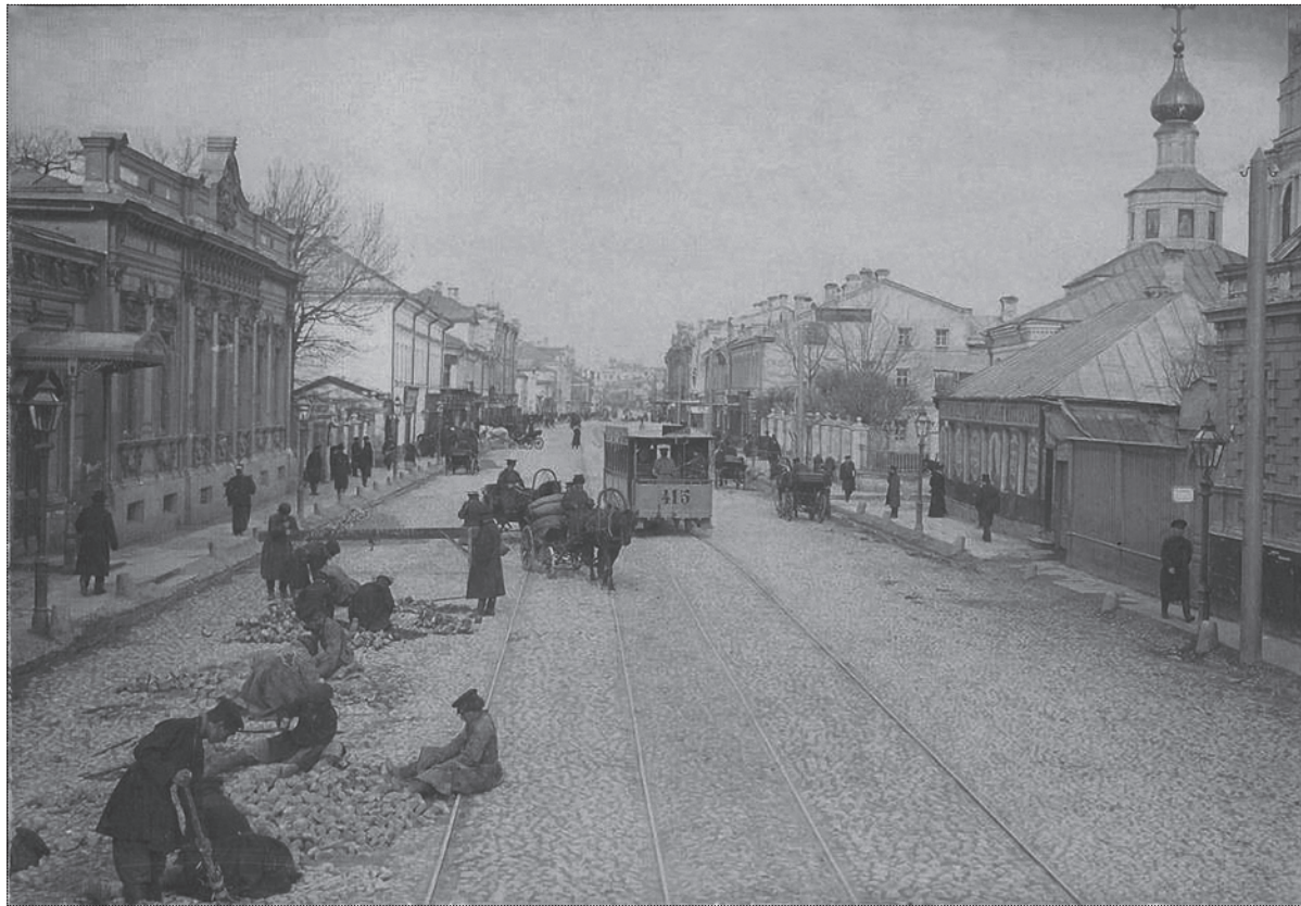
Дорожные работы на Арбате в районе нынешнего дома 42. Фото 1880–1900 годов
