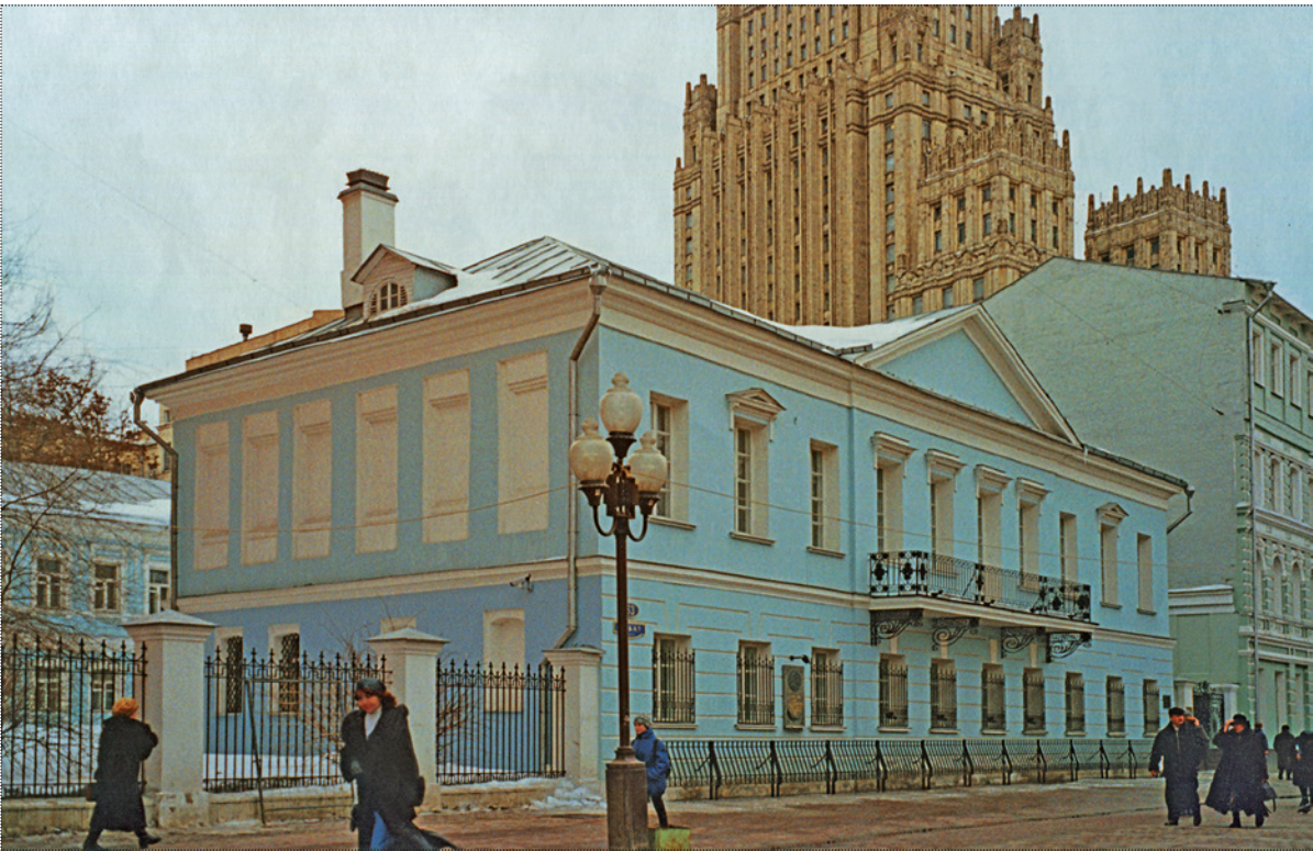
Фасад здания после реставрации. Фото: Б. Томбак, 1987 год
