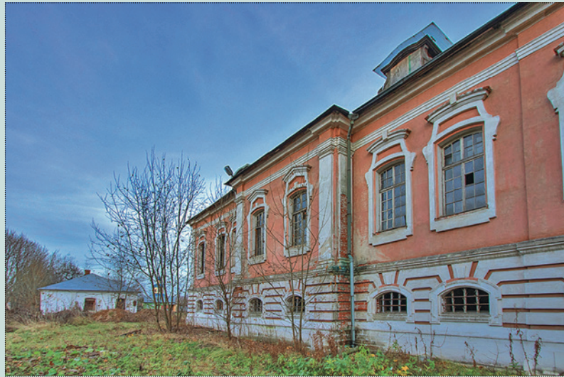
Господский дом усадьбы Ясенево. Западный фасад. Фото: А. Александрова, 2021 год
