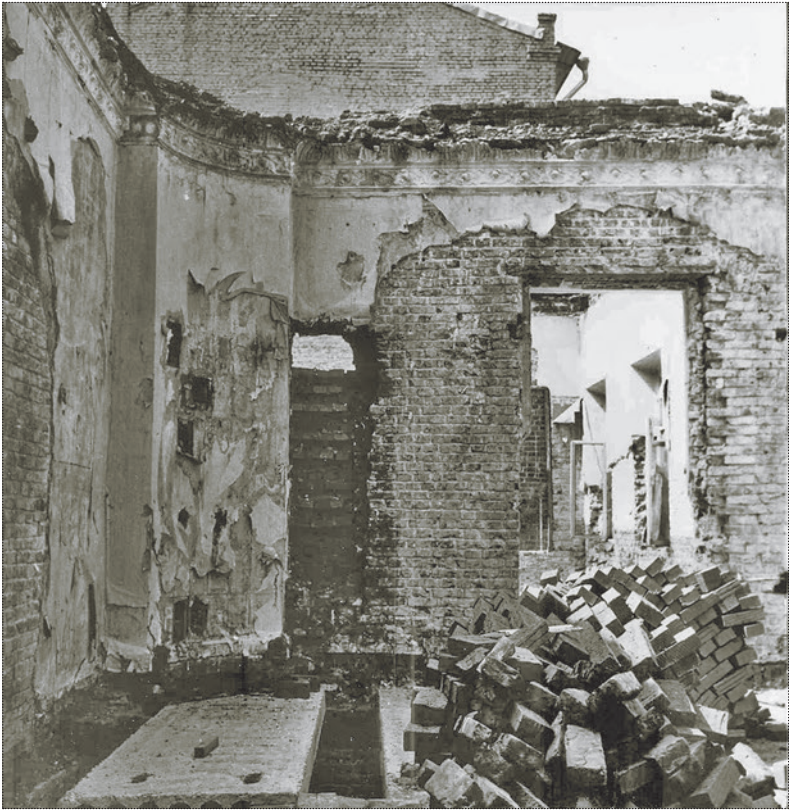
Центральная гостиная второго этажа во время работ. Фото 1979 года
