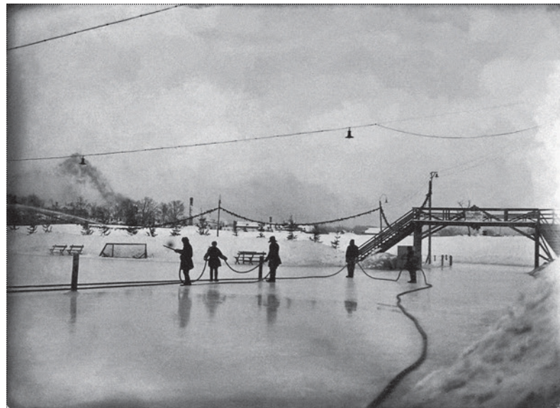
Центральный стадион Московских Металлистов. Заливка катка. Фото 1929 года
