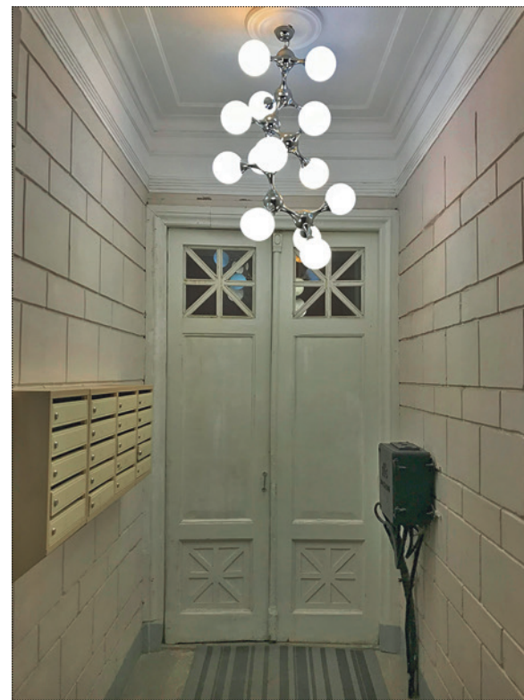
Входная группа подъезда до и после ремонта. Фото автора и Е. Крижевской
