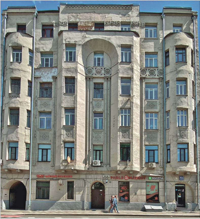
Фасад дома по улице Большая Ордынка. Фото: Мосгорнаследие, 2025 год
