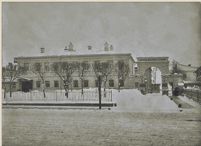
Здание больницы Св. Ольги со съездной аркой. Фото МБУ «Краеведческий музей городского округа Сызрань»
