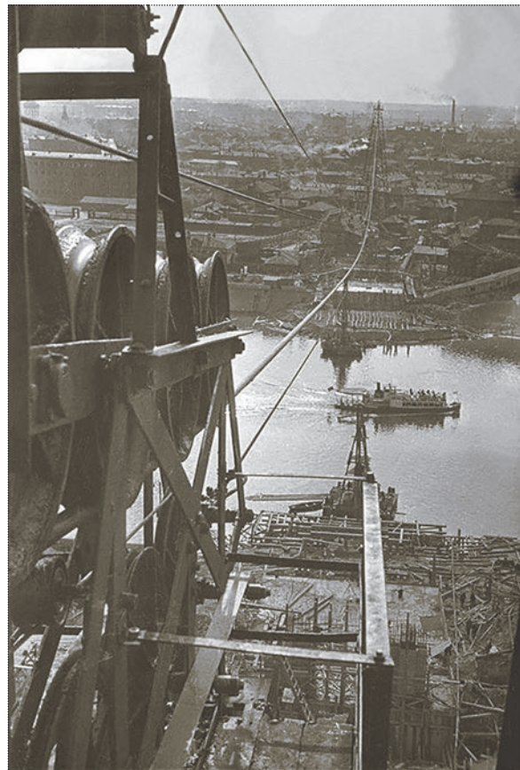
Строительство Смоленского метромоста. Фото: В.В. Микоша, 1935–1936 годы
