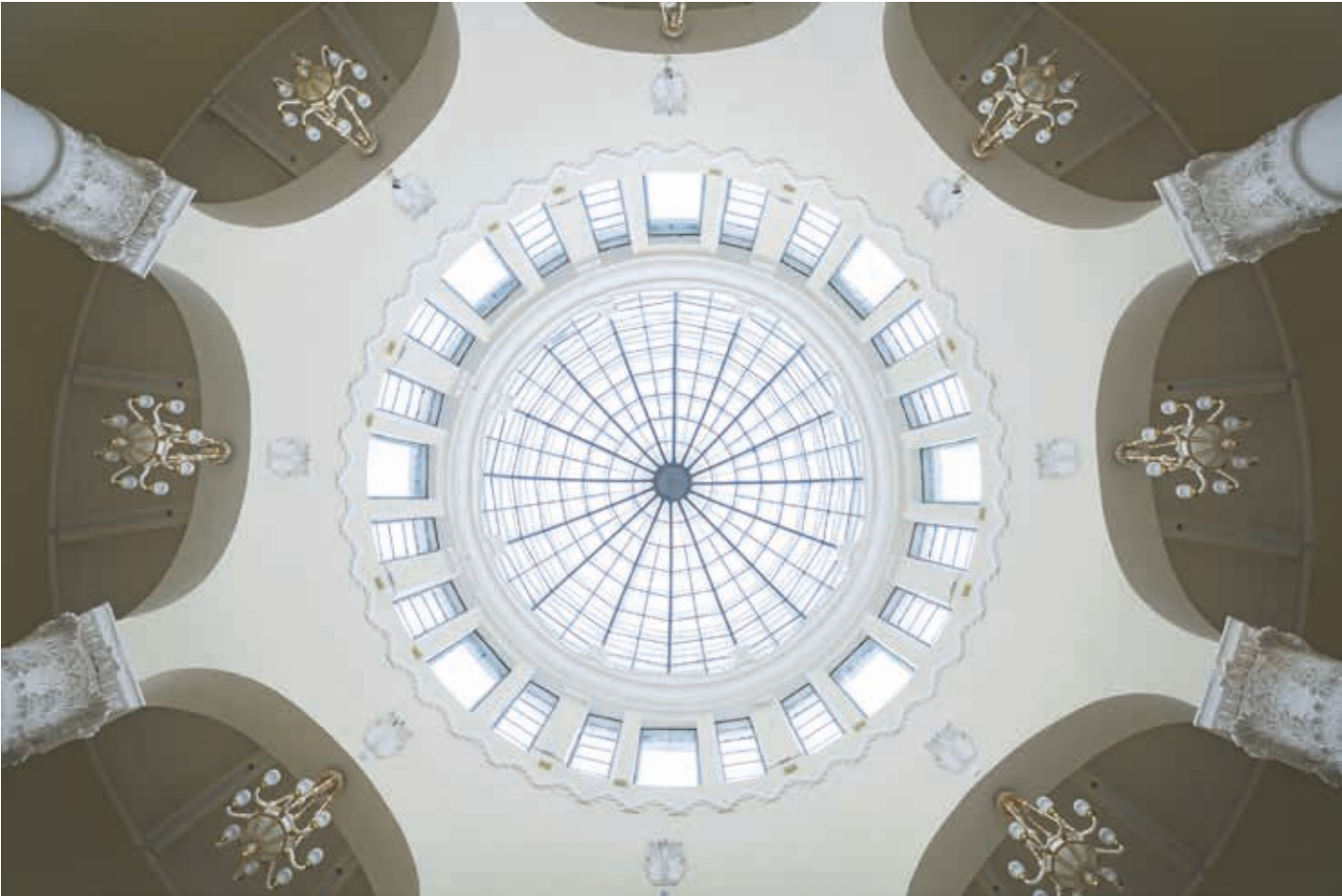
(6) Зал организационной работы после завершения реставрации. 2025 год
