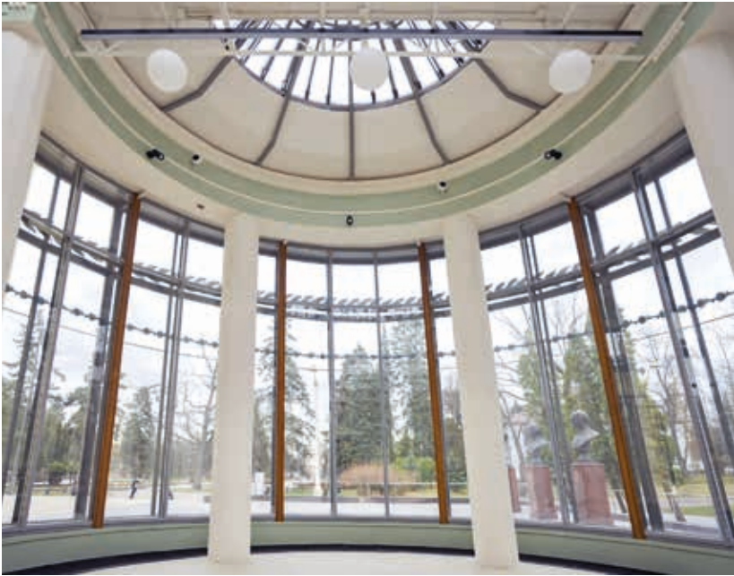
(2) Оранжерея после завершения работ. 2025 год
