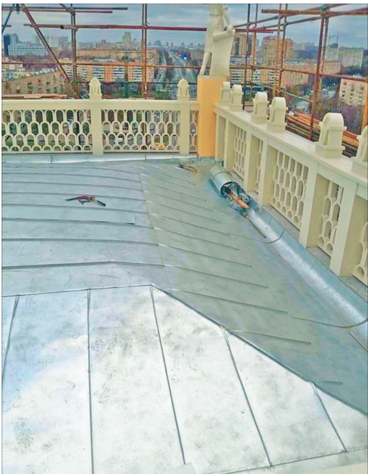
Устройство покрытий кровли, карнизных свесов, примыканий к стенам
