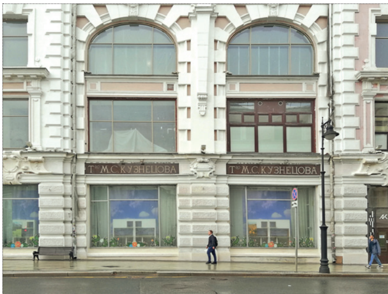
Фасад здания Правления Товарищества Кузнецова. Мясницкая улица, дом 8/2, строение 1. 1898–1903 годы. Фото: А. Сидельников, 2021 год
