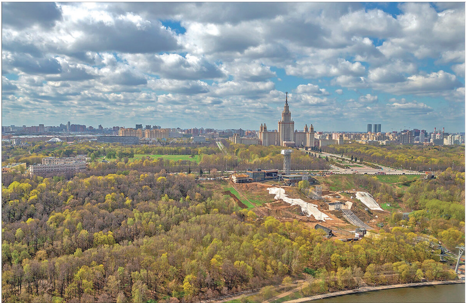
Панорама строительства горнолыжного комплекса на Воробьёвых горах. Фото: М. Лысцева, 2021 год
