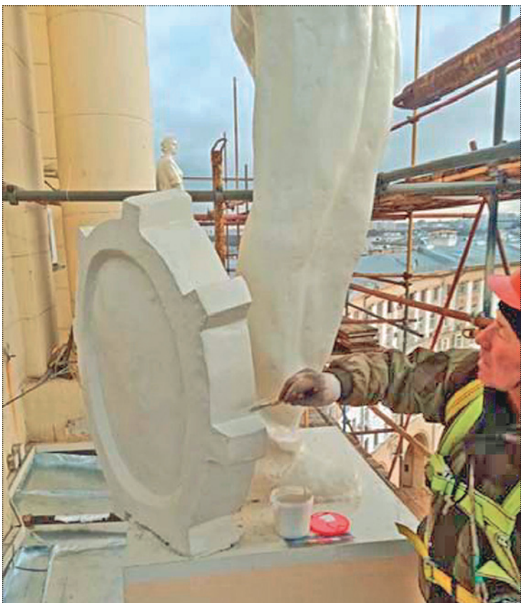
Грунтование и покраска поверхности скульптур верхнего и нижнего ярусов. «Рабочий»
