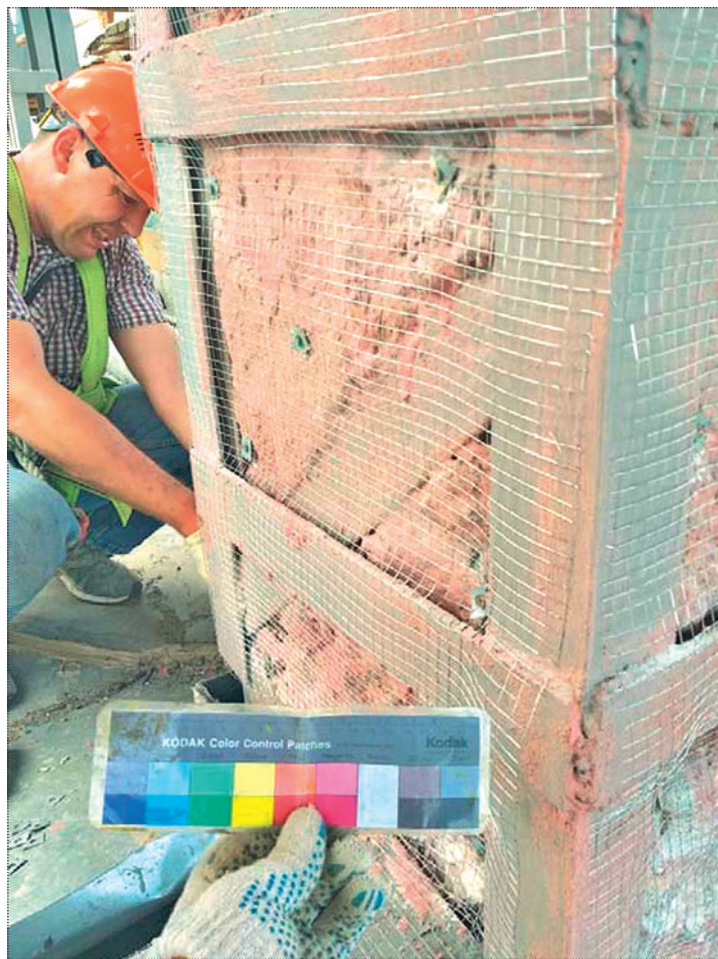
Устройство основания под штукатурку из металлической сетки по кирпичным и бетонным поверхностям (установка штукатурной сетки на стены постаментов скульптур верхнего и среднего ярусов)
