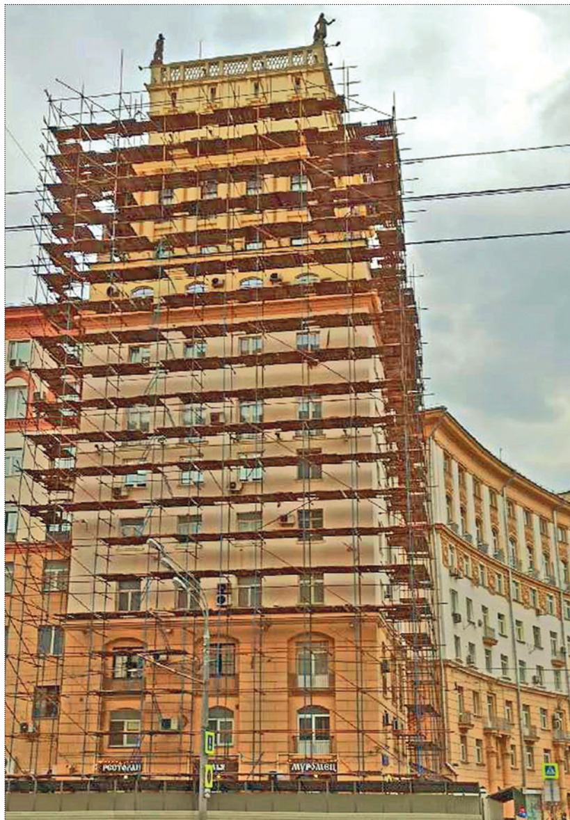
Сборка и установка выпускных лесов. Все фото далее: ГКУ «Мосреставрация», 2020 год
