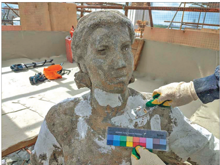
Восстановление утраченных элементов верхней скульптуры (мастиковка и восстановление)
