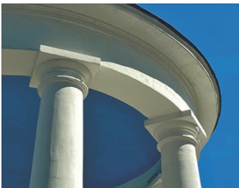
Ротонды Голицынской больницы входят в число объектов культурного наследия федерального значения. Фото: Мосгорнаследие, 2021 год
