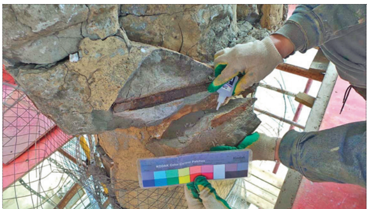
Склейка фрагментов разрушенных частей нижних скульптур
