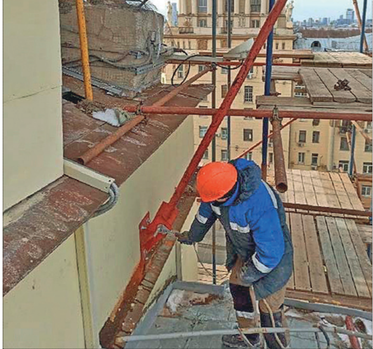
Устройство металлических инвентарных лесов на фасадах и кровле
