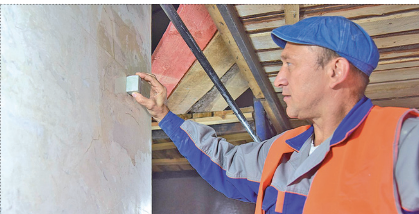
В марте этого года началась комплексная реставрация здания исторической пожарной части в районе Преображенское. Фото: Пресс-служба Мэра и Правительства Москвы, 2021 год
