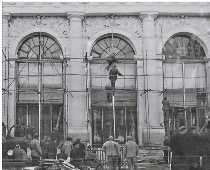
Манеж. Установка лесов для производства реставрационных работ. Архив Д.Н. Кульчинского
