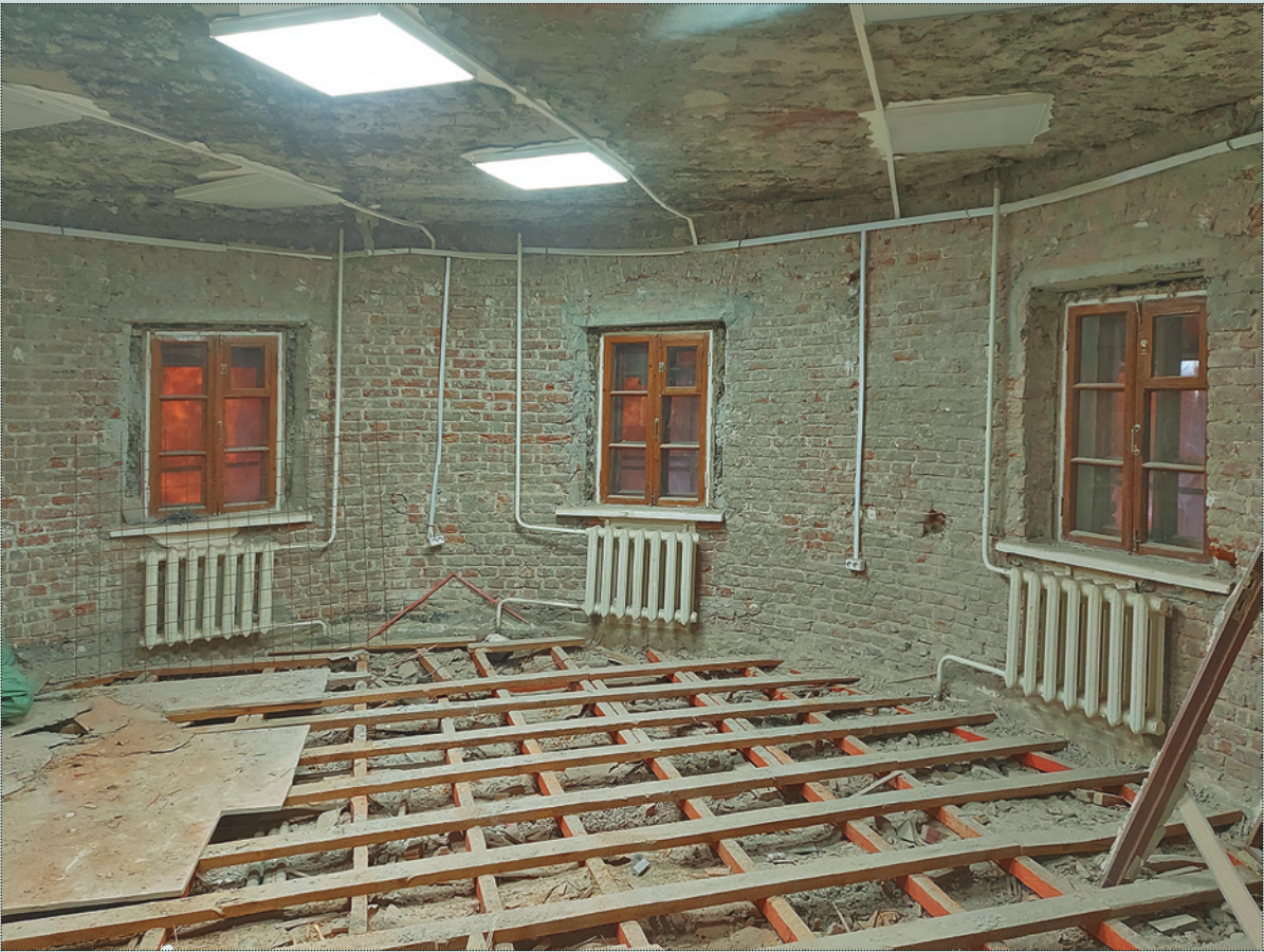
Помещение в ходе реставрационных работ. Фото 2022 года
