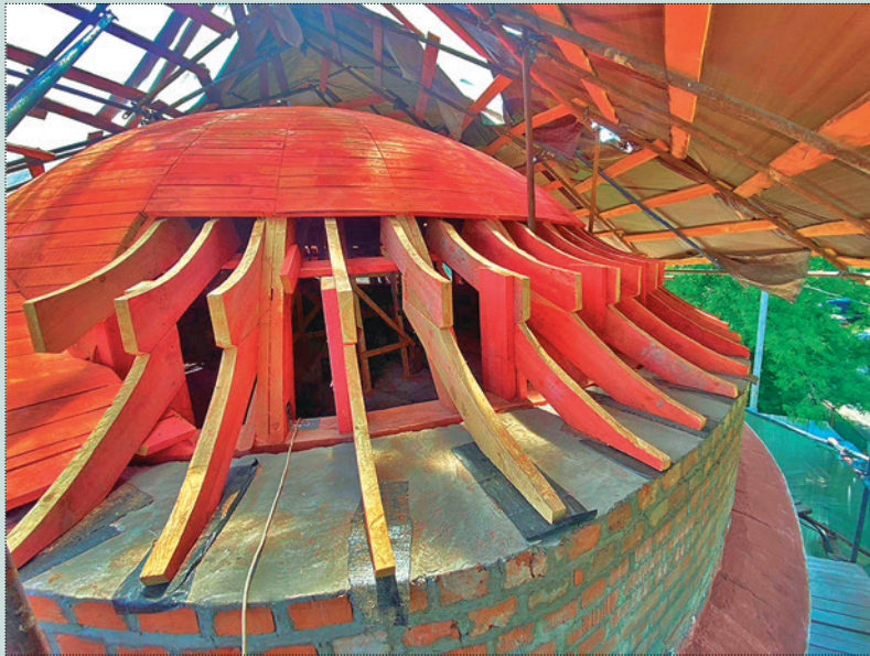
Воссоздание купольного завершения над объёмом полуротонды. Фото 2023 года
