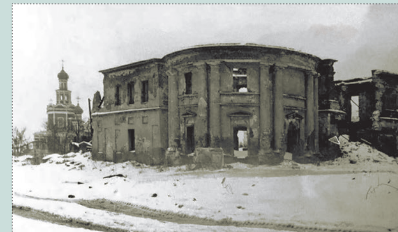
Юго-западный фасад южного флигеля. Фото 1960-х годов. Отдел архивных фондов Мосгорнаследия
