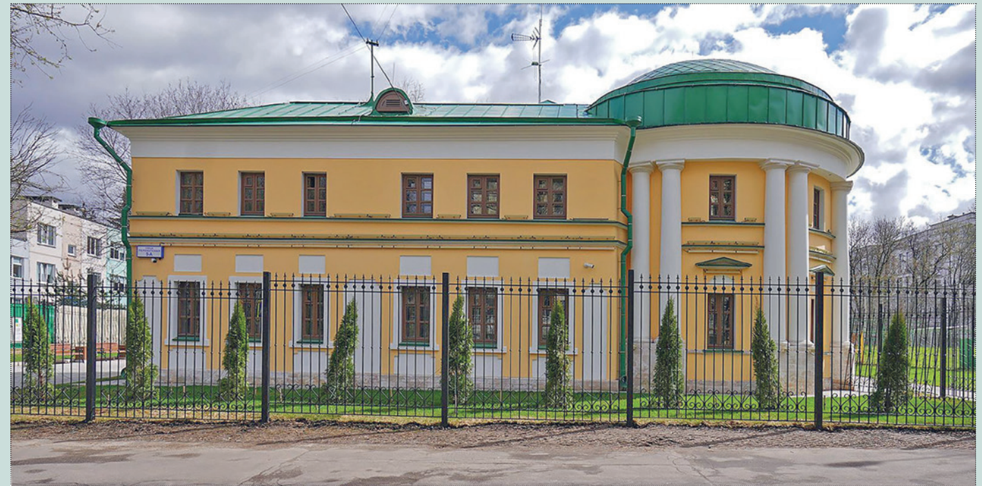
В марте этого года завершилась реставрация южного флигеля усадьбы Прозоровских. Фото: Е. Самарин / mos.ru, 2024 год
