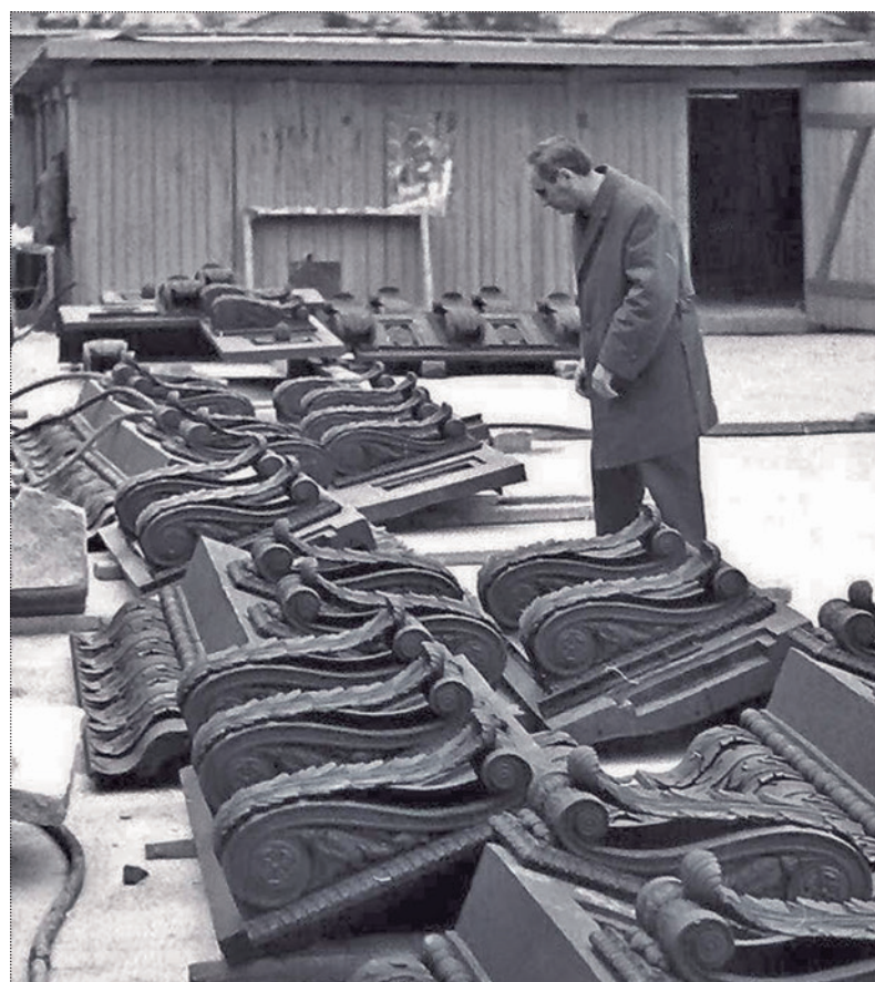
Детали карниза арки, подготовленные для монтажа. Архив Д.Н. Кульчинского
