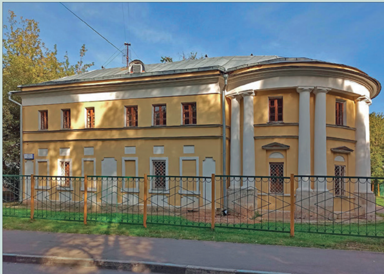
Южный флигель до начала реставрационных работ. Фото 2022 года
