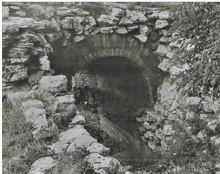
Фрагмент циклопической кладки Грота до реставрации. Архив Д.Н. Кульчинского
