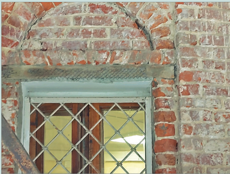
Фрагмент расчищенного оконного проёма. Фото 2022 года
