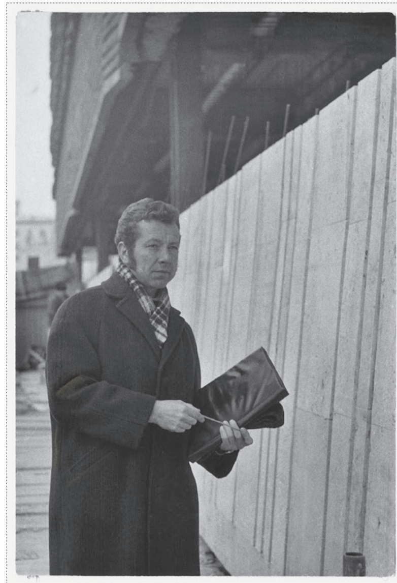
Архитектор В.С. Кубасов у главного фасада строящегося здания МХАТ им. М. Горького на Тверском бульваре. Начало 1970-х годов. Все иллюстрации далее: ГНИМА им. В.А. Щусева
