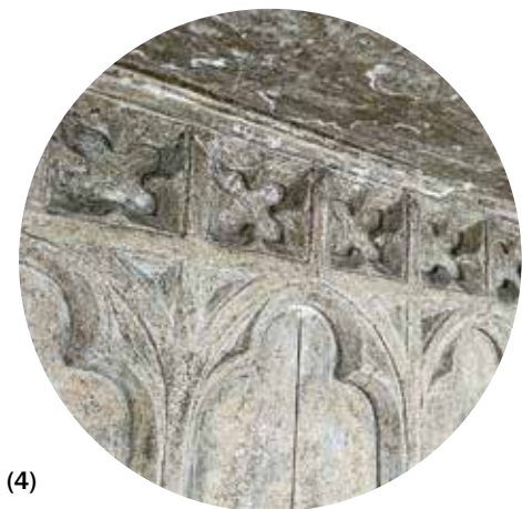
(4, 5) Растительный орнамент после расчистки и после реставрации (после нанесения каменной штукатурки)
