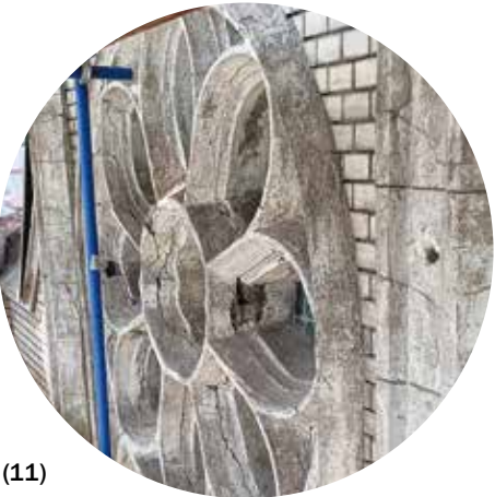
(11) Окно-роза, состояние после расчистки позднего отделочного слоя (12) Окно-роза, состояние после реставрации
