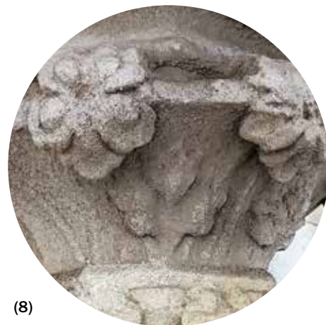
(8, 9) Растительный декор во время работ и после реставрации (после нанесения каменной штукатурки-ретуши)
