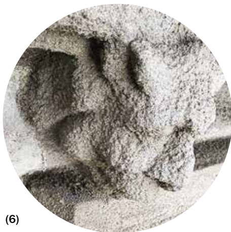
(6, 7) Декор и профилированные элементы с угротой рельефа под поздними покрытиями и после расчистки
