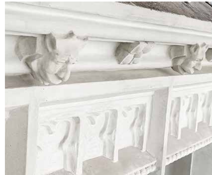
(10) Маскароны и профилированные элементы после нанесения ретуши и терразитовой штукатурки
