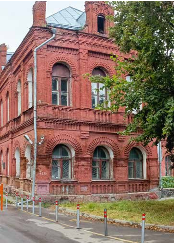
Господский дом В.И. Йокиша. 2024 г. Фото автора Главная аллея парадного двора усадьбы Михалково. 2024 г. Фото автора
