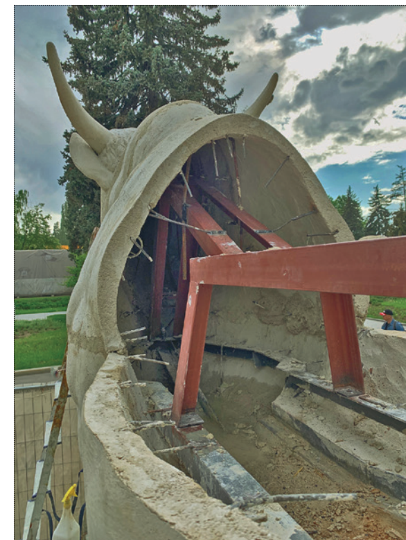
Монтаж второго фрагмента верхнего пояса
