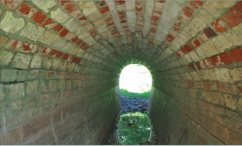
Декоративная кладка арки моста в усадьбе Воронцово. Фото автора, 2020 год
