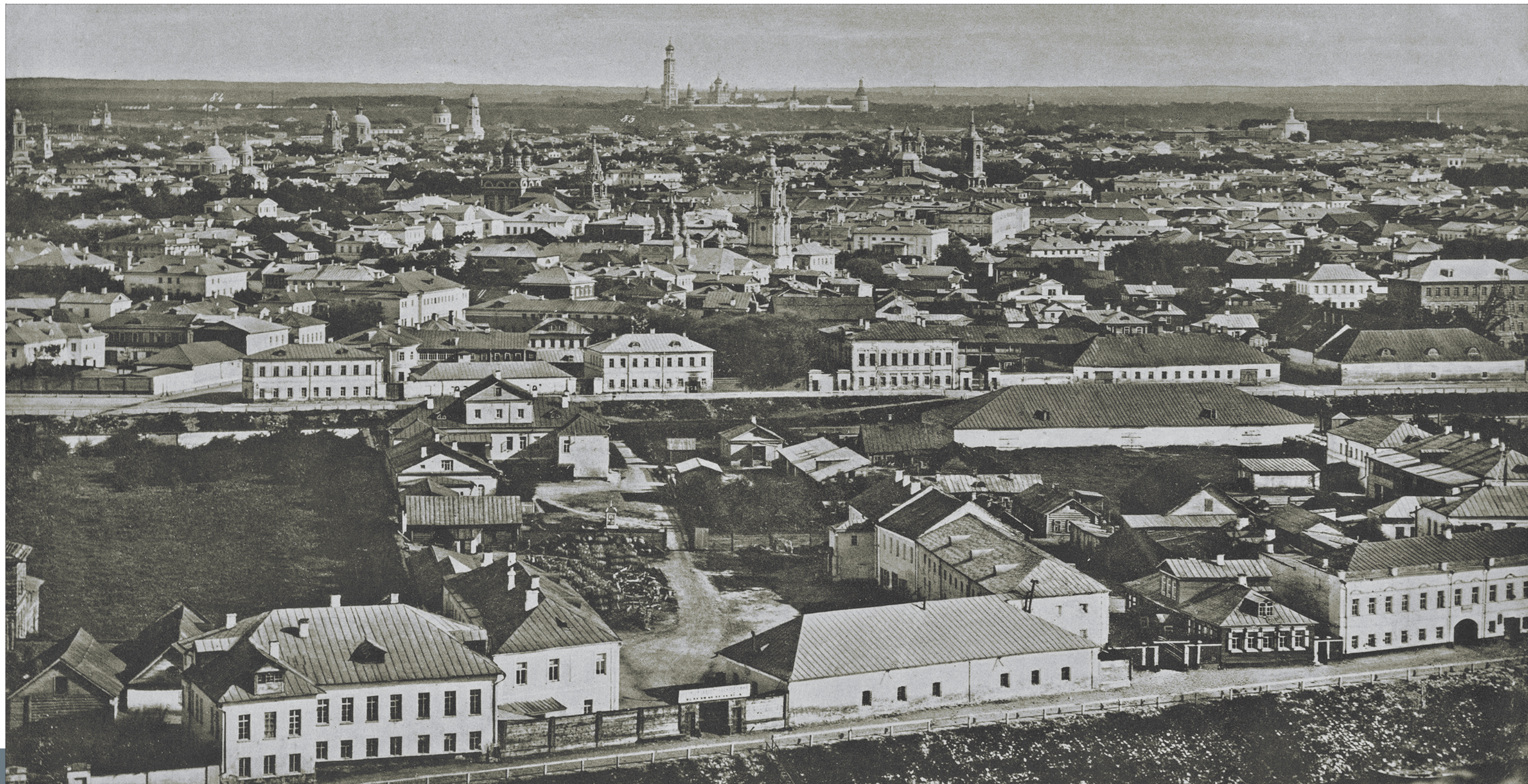
Фрагмент круговой панорамы, снятой с крыши строящегося Храма Христа Спасителя. 1867 год. В кадр попадает почти всё Замоскворечье от Берсневской набережной до границ города
