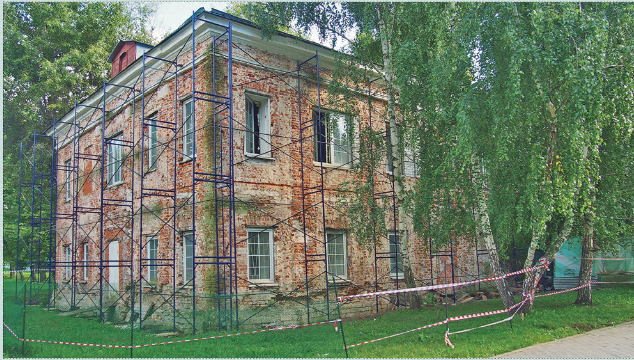
Кухонный флигель перед установкой фальшфасадов. Фото автора, 2016 год
