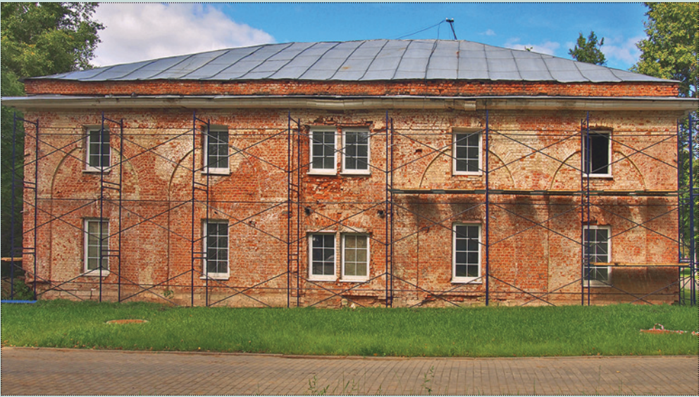
Людские комнаты конного двора перед установкой фальшфасадов. Фото автора, 2016 год
