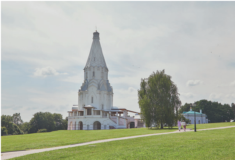
Общий вид церкви Вознесения. 2025 год
