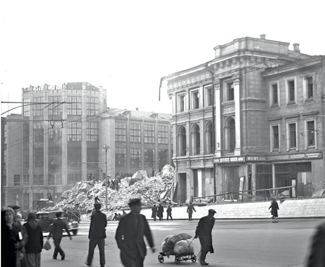
Снос дома на углу улицы Огарёва (ныне — Газетный переулок) и Тверской улицы. 1930-е годы. Документальный фонд Мосгорнаследия
