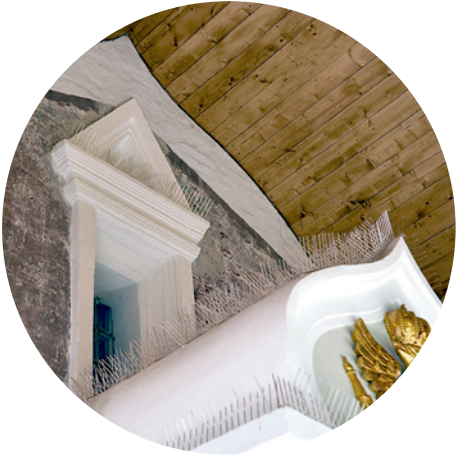
Состояние после завершения работ. Биопоражение и разрушения вследствие действия солей полностью устранены. 2025 год
