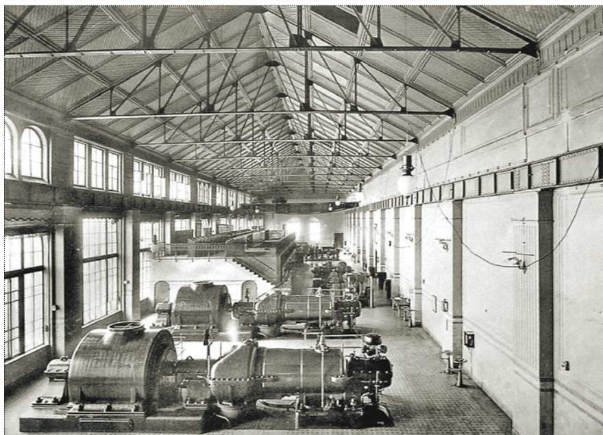
Центральная электрическая станция. Машинное отделение. Фото начала XX века
