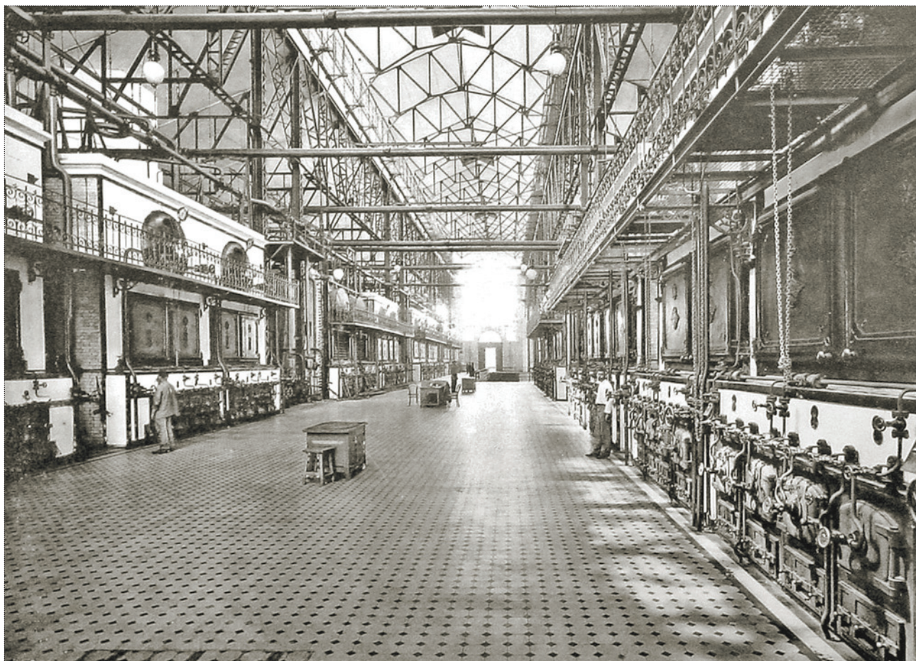
Интерьер Центральной электростанции трамваев. Зал газовых паровых котлов. Фото 1907–1917 годов
