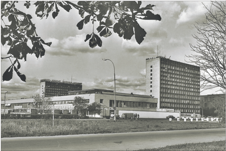
Здание Центрального аэровокзала с гостиницей и административным корпусом на Ленинградском проспекте. 1957–1958 годы
