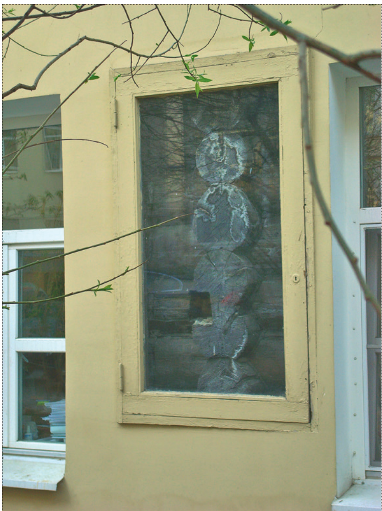
Фрагмент деревянного сруба, оставленного при реставрации конца 1960-х годов. Фото автора, 2017 год
