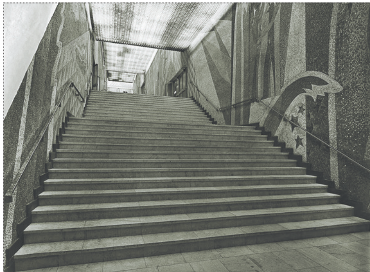
Олимпийский телерадиокомплекс. Интерьер. Главная лестница. 1980–е годы
