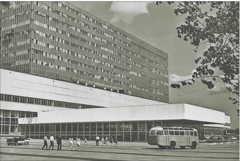
Телевизионный технический центр в Останкине. 1970–е годы
