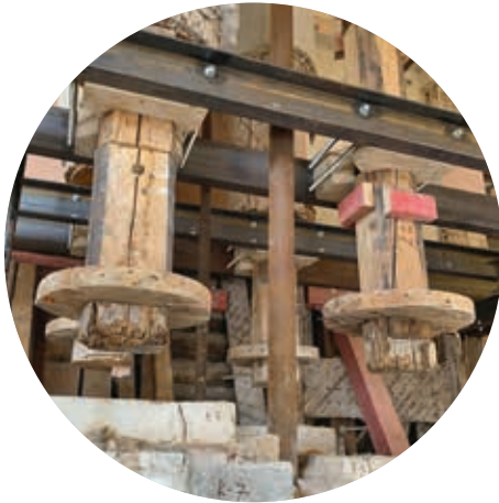
Вывешивание колонн портика. Фрагмент
