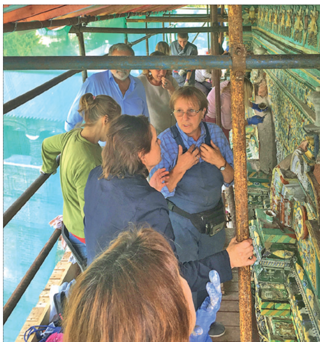
Обсуждение хода реставрационных работ на Крутицком теремке. В центре – руководитель работ О.И. Власенко (АО «МНРХУ»), слева – автор статьи. Фото 2018 года
