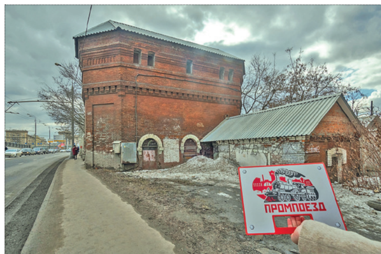
Фрагмент водоёмного здания 1901 года с насосной станцией. Фото автора, 2019 год
