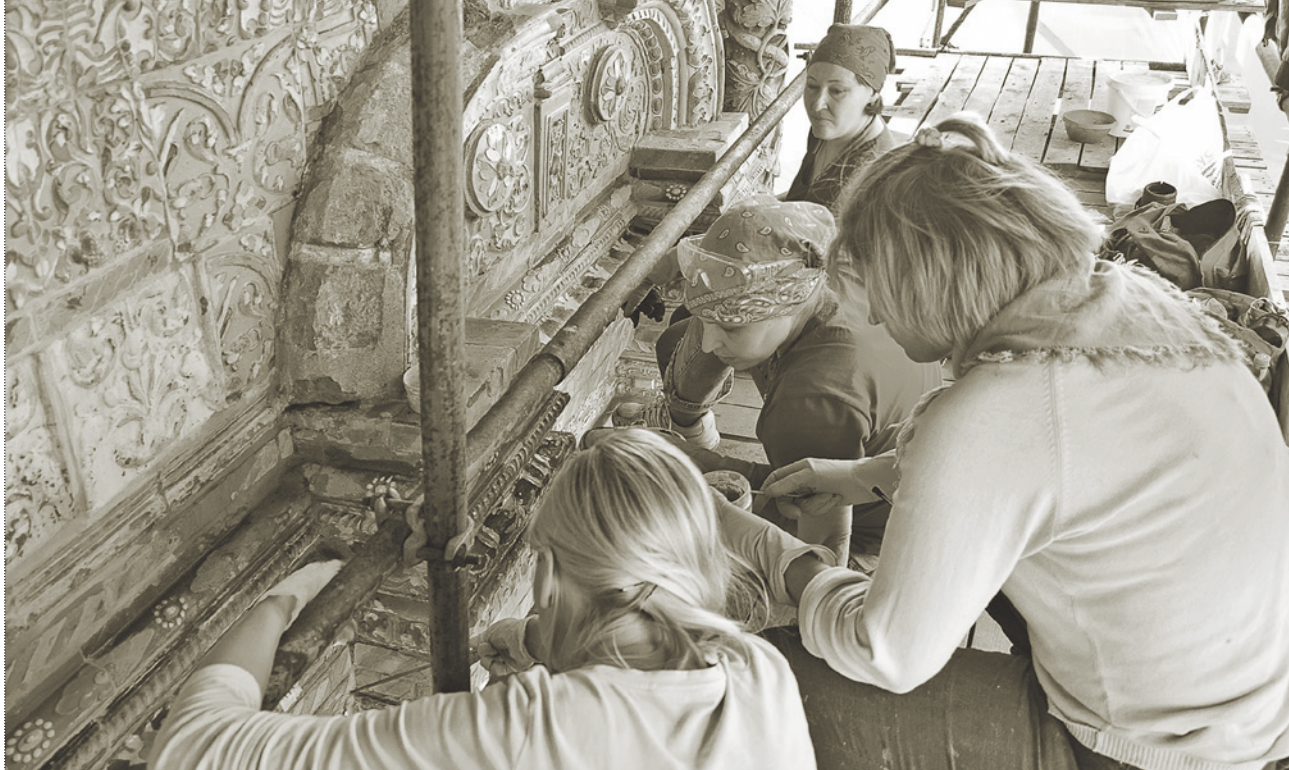
Реставрационные работы на северном фасаде Крутицкого теремка реставраторами АО «МНРХУ». Фото 2018 года. Архив автора
