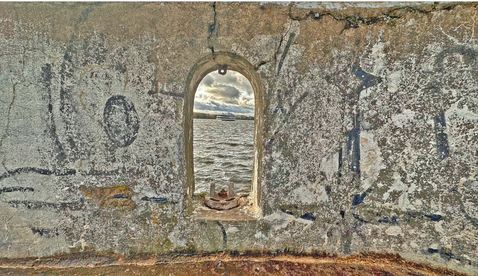
Заградительные ворота канала Москва – Волга на Икшинском водохранилище. Фото: Ф. Смирнов, 2023 год
