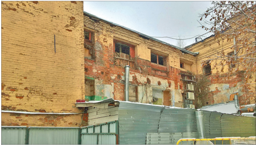
Дворовый фасад до и после проведения реставрационных работ
