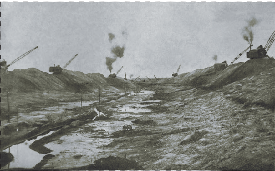
Земляные работы на 9-м километре канала Москва – Волга. Фото 1935–1936 годов
