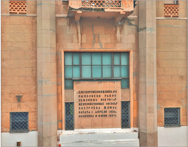
Памятная табличка с перечнем работ на фасаде Башни управления Шлюза № 6 в Икше. Фото автора, 2023 год
