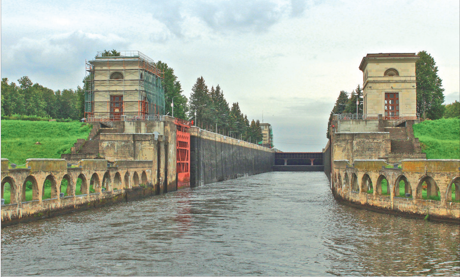
Подход к Шлюзу № 1 в Дубне. Архитектор И.К. Белдовский. Фото автора, 2023 год
