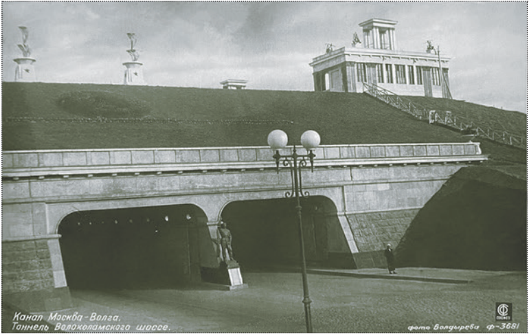
Тоннель Волоколамского шоссе. Архитектор В.Ф. Кринский. У входов в тоннель были установлены скульптуры лётчика и парашютистки скульптора В.П. Шварца, напоминавшие о находившемся поблизости Тушинском аэродроме. Почтовая карточка 1939 года из архива автора
