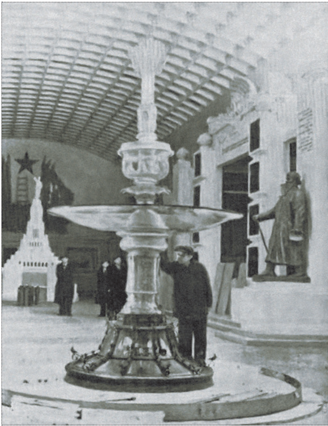
Монтаж Хрустального фонтана в Главном павильоне ВСХВ. Фото из газеты “Сіпа” от 29 мая 1941 года. С. 3
