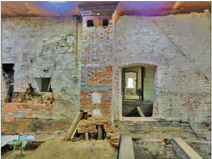
Интерьер здания до и после реставрационных работ
