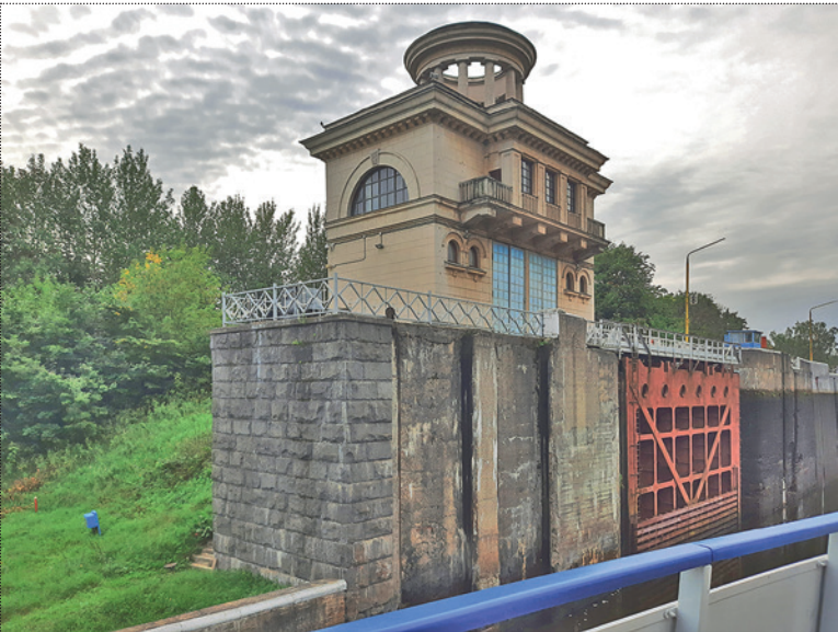
Башня управления нижней головы Шлюза № 5 в Икше. Архитектор Д.Б. Савицкий. Фото автора, 2023 год
