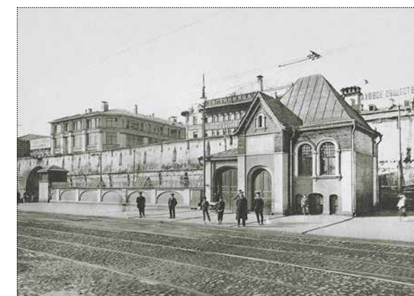
Лубянская электрическая подстанция. Фото 1910 года. Из-за стеснённых условий техническая часть была устроена под землёй на глубине более 6 метров. Не сохранилась
