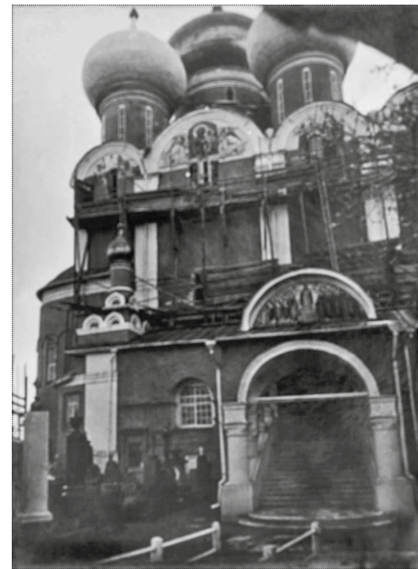
Вид на северный фасад Смоленского собора во время реставрации в лесах. Фото 1898 года. ГИМ
