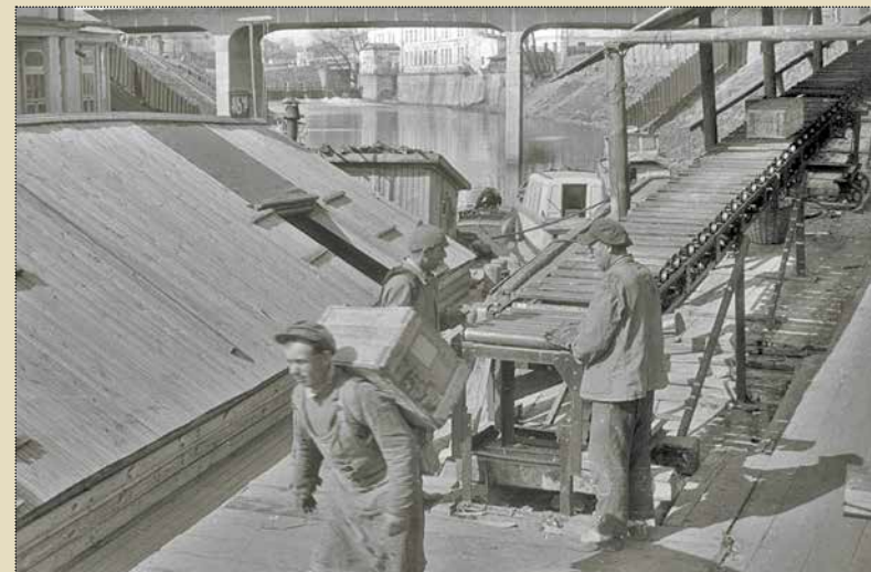
Загрузка баржи при помощи ленточного транспортёра на Причальной набережной в Москве. Вид в сторону Краснохолмской плотины. 1935 год. РГАКФД
