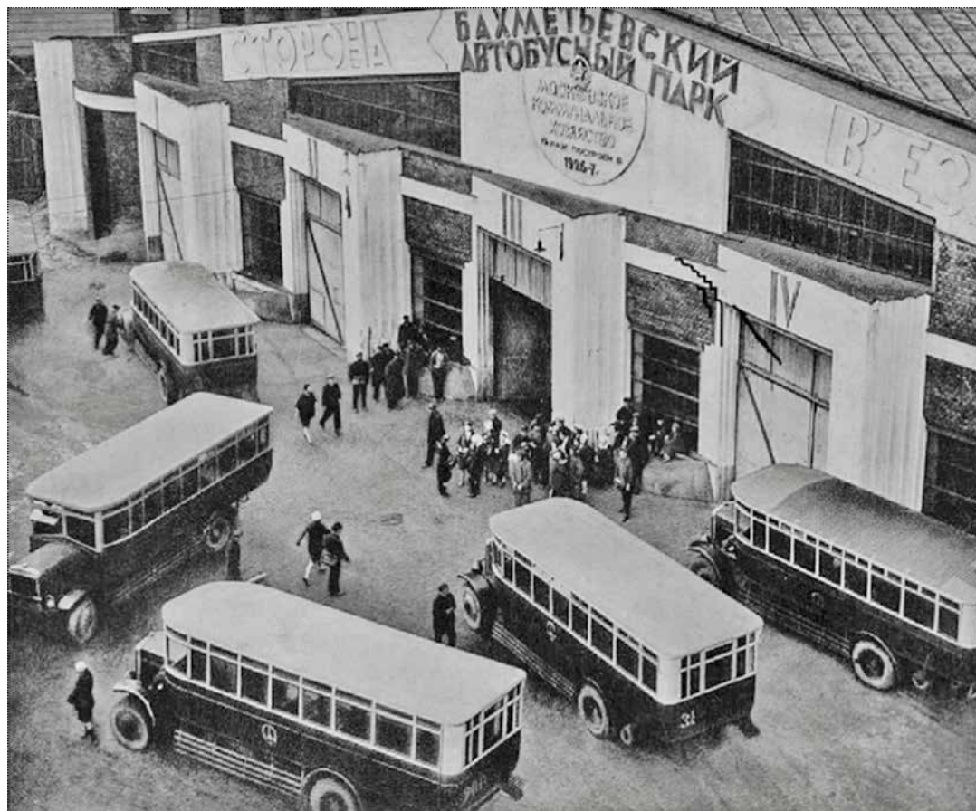
Бахметьевский автобусный парк. Главный фасад с автобусами «Лейланд». Фото 1931 года
