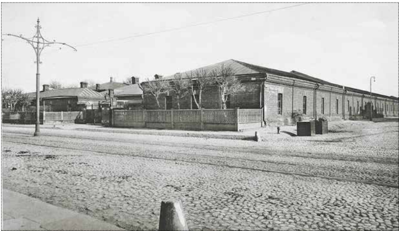
Здания бывшего Ремизовского парка конно-железных дорог на Коровьем валу. 1910 год
