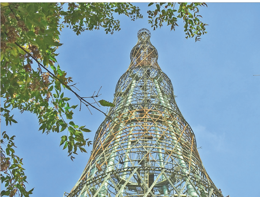
В 2016 году на башне провели противоаварийные работы. Фото Владимира Шухова, сентябрь 2021 года
