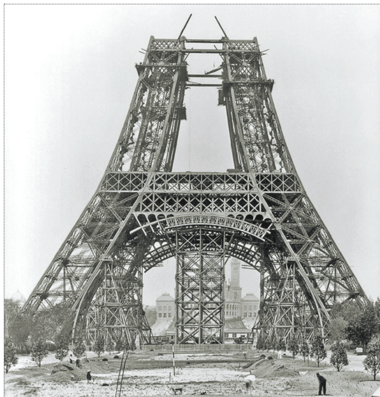
Строительство Эйфелевой башни. Фото 1888 года
