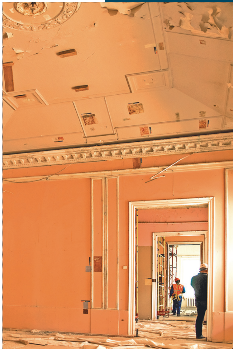
Обследование перекрытия в одном из помещений здания. Фото: Мосгорнаследие, 2019 год
