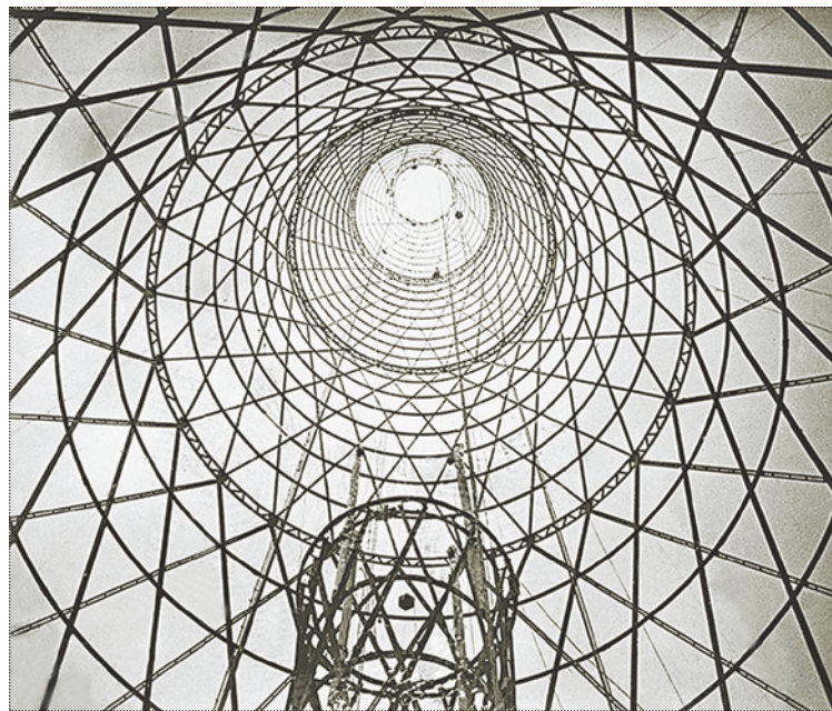
Телескопический метод монтажа. Поднимается последняя, шестая секция. Стереофотоснимок В.Г. Шухова. Семейный архив
