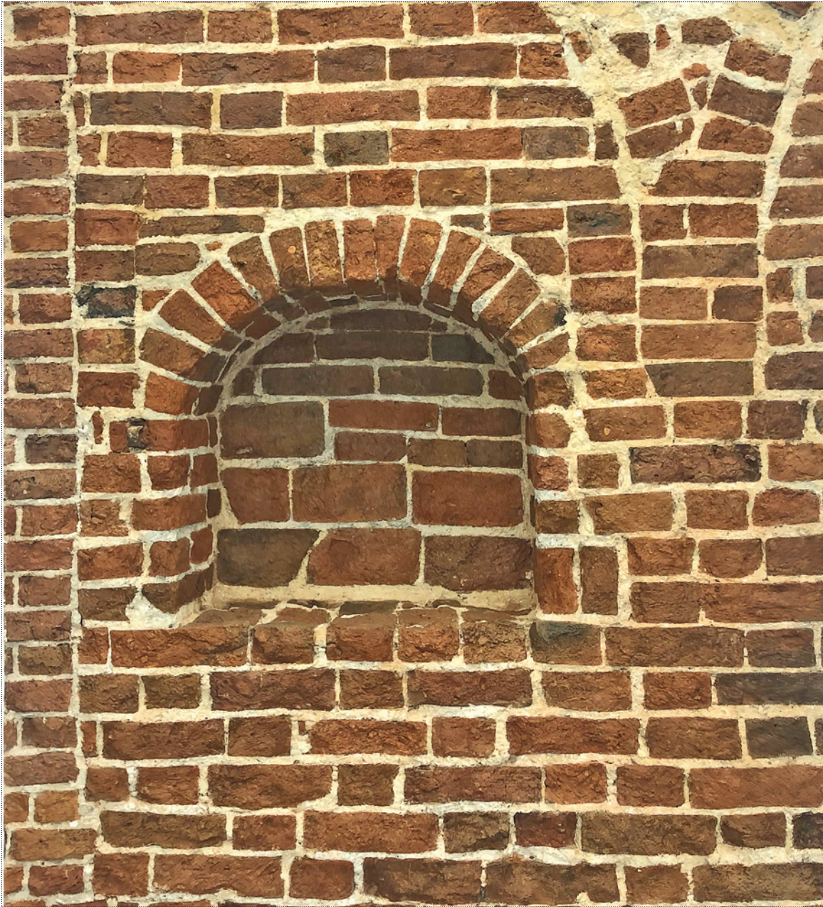
Печура на стене 2-го этажа после реставрации. Фото 2018 года
