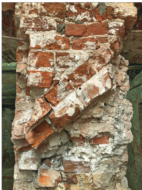
Раскрытие фрагмента наличника окна 1-го этажа в простенке. Фото 2018 года
