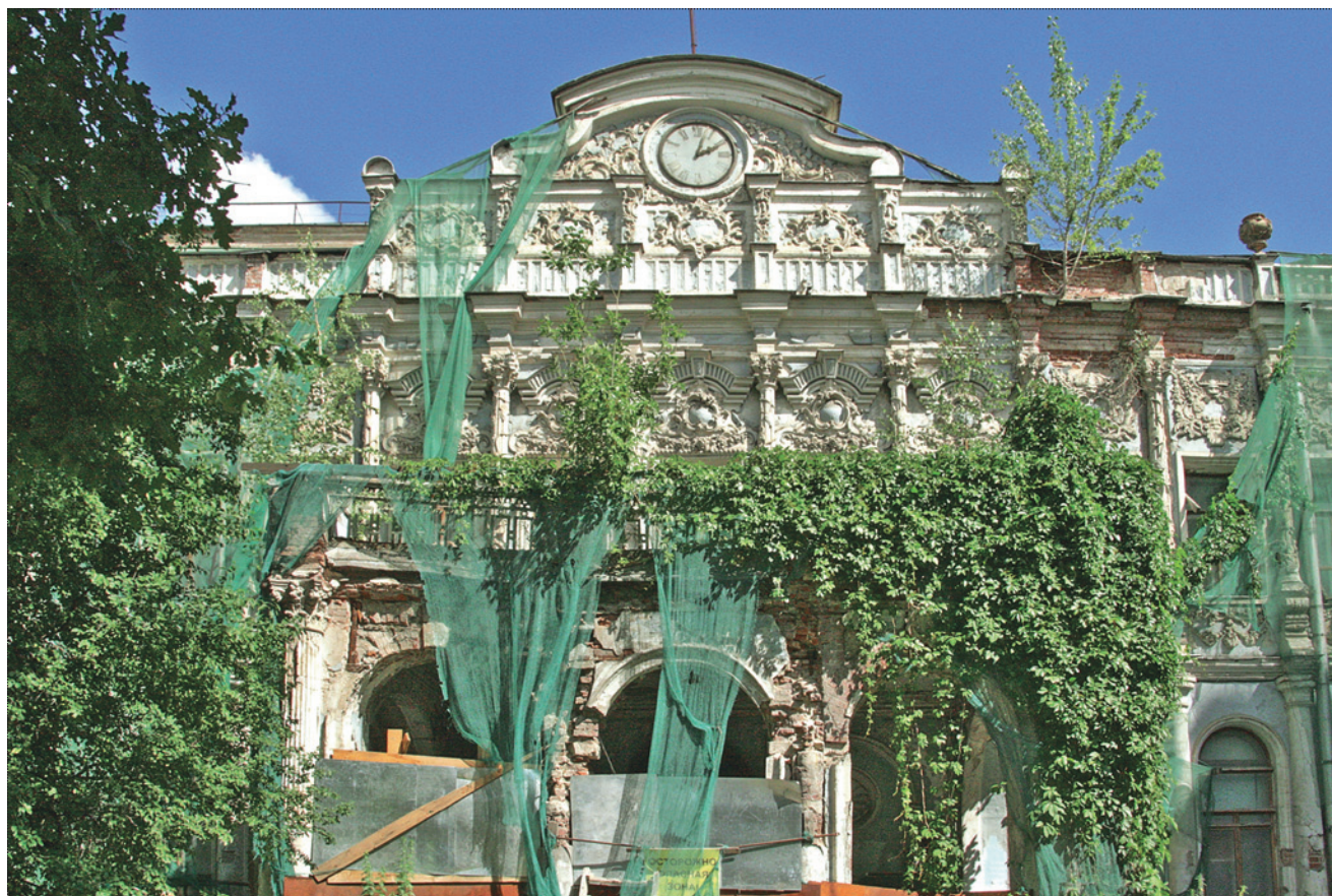
Состояние главного фасада в 2016 году
