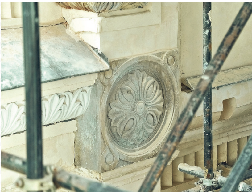
Тондо из песчаника на западном фасаде храма. Проведена расчистка и укрепление камня. Фото: Р.В. Ковальский, 2020 год
