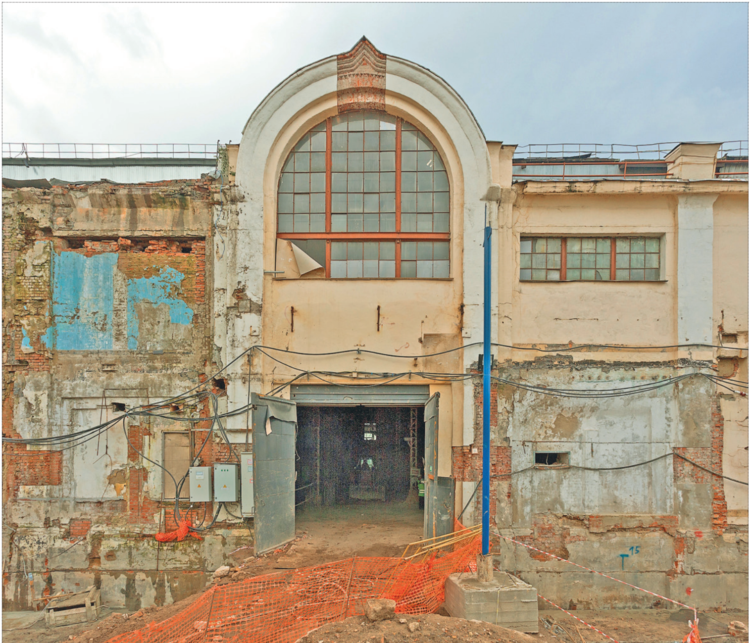
Западный фасад до реставрации. Фото: РСК «ЭКОБАУ», 2017 год
