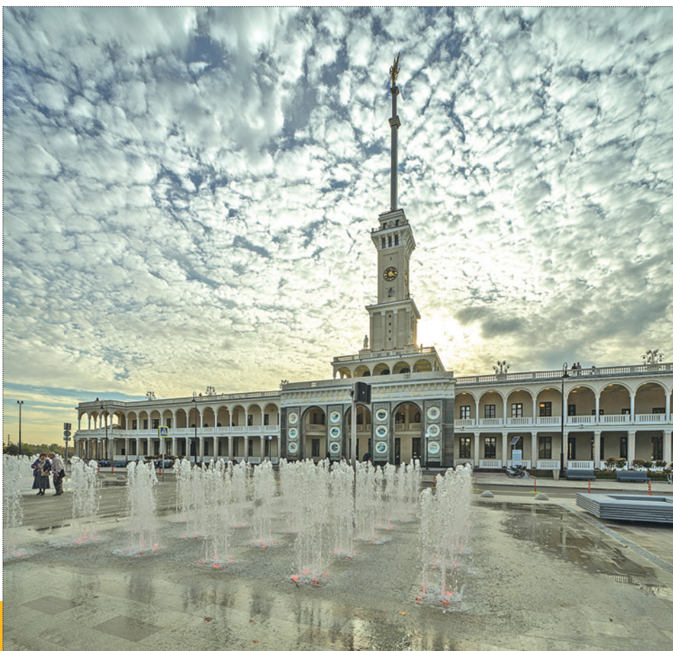
Главный фасад после реставрации. Фото: Е. Крижевская, 2020 год
