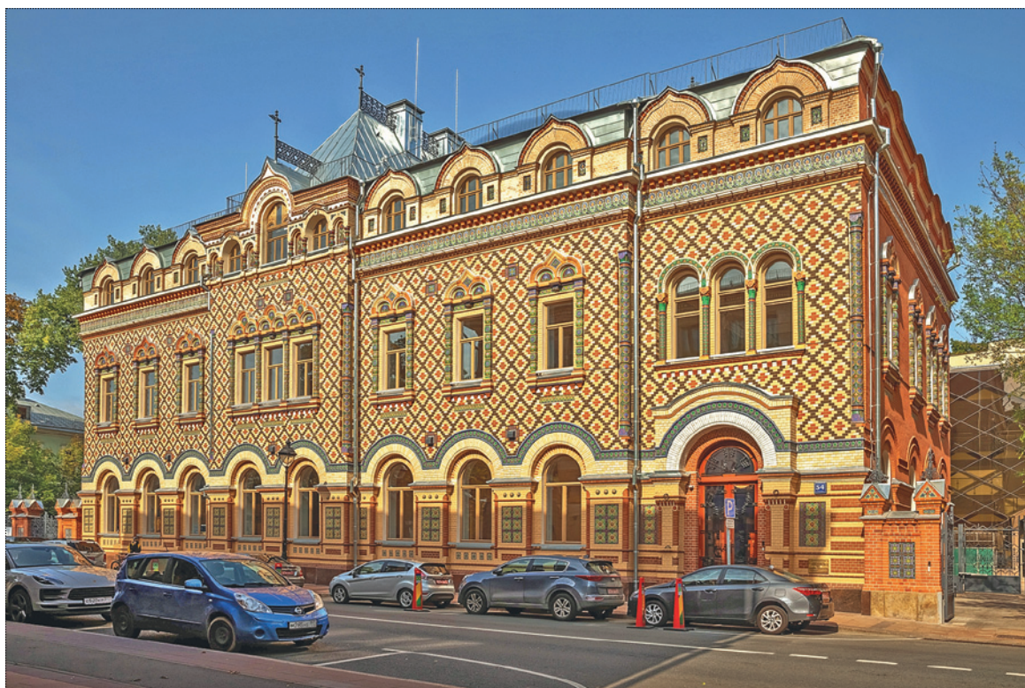
Фасад здания после реставрации. Фото 2020 года
