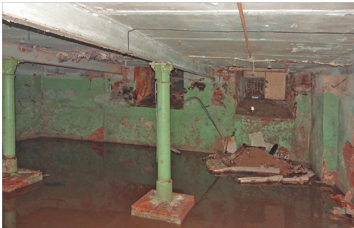
Подвальный этаж с чугунными колоннами до реставрации. Фото 2014 года
