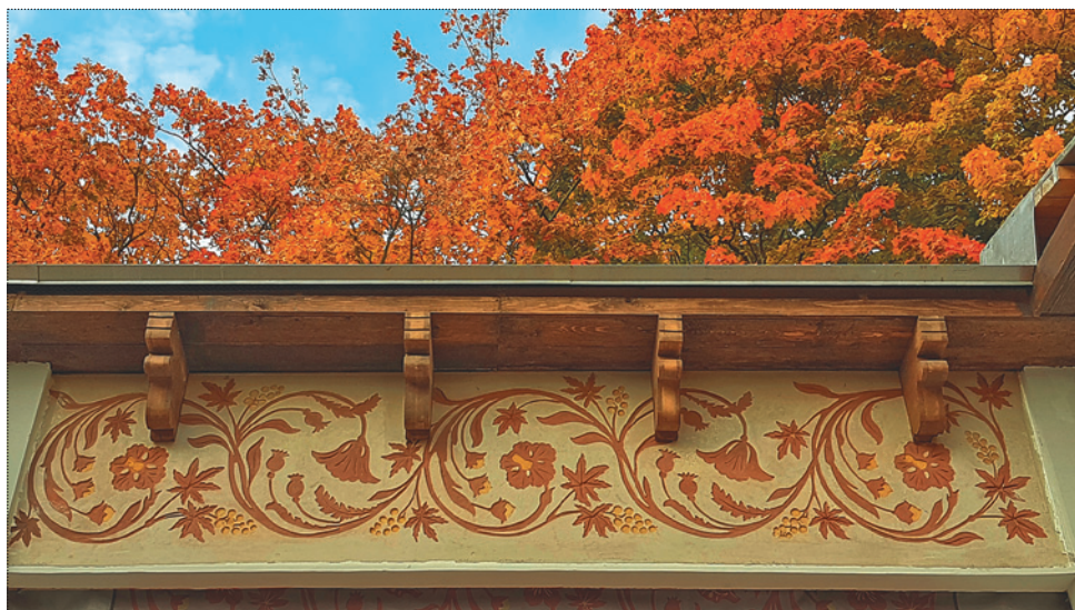
Установка панели сграффито на свое место на фасаде. Фото: ТМ «КИТЕЖ», 2020 год
