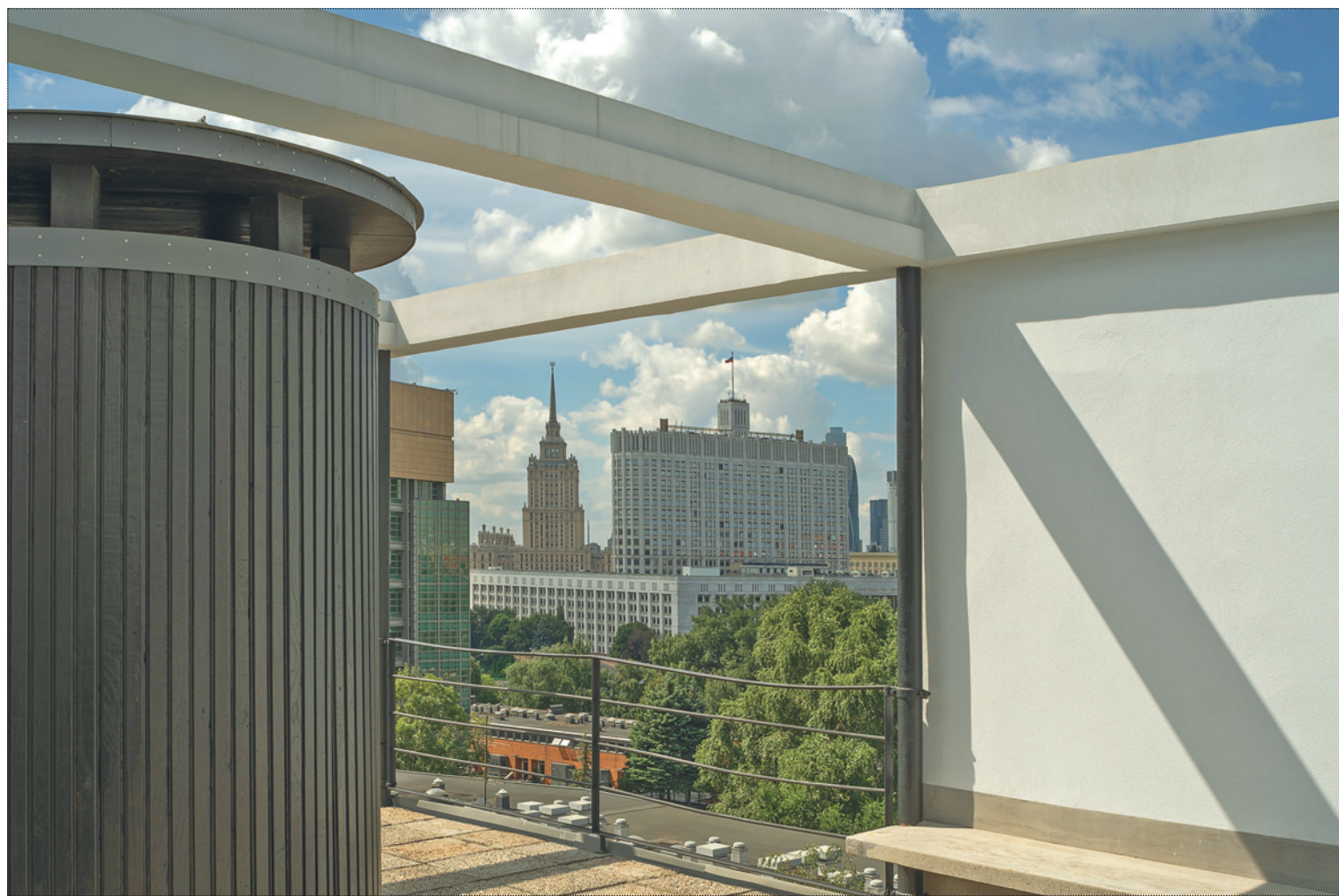
Вентиляционные шахты на кровле. Фото: Ю. Пальмин, 2020 год
