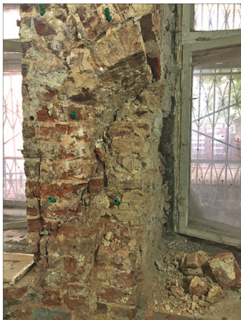
Простенок окон 1 этажа в процессе реставрации. Фото 2018 года
