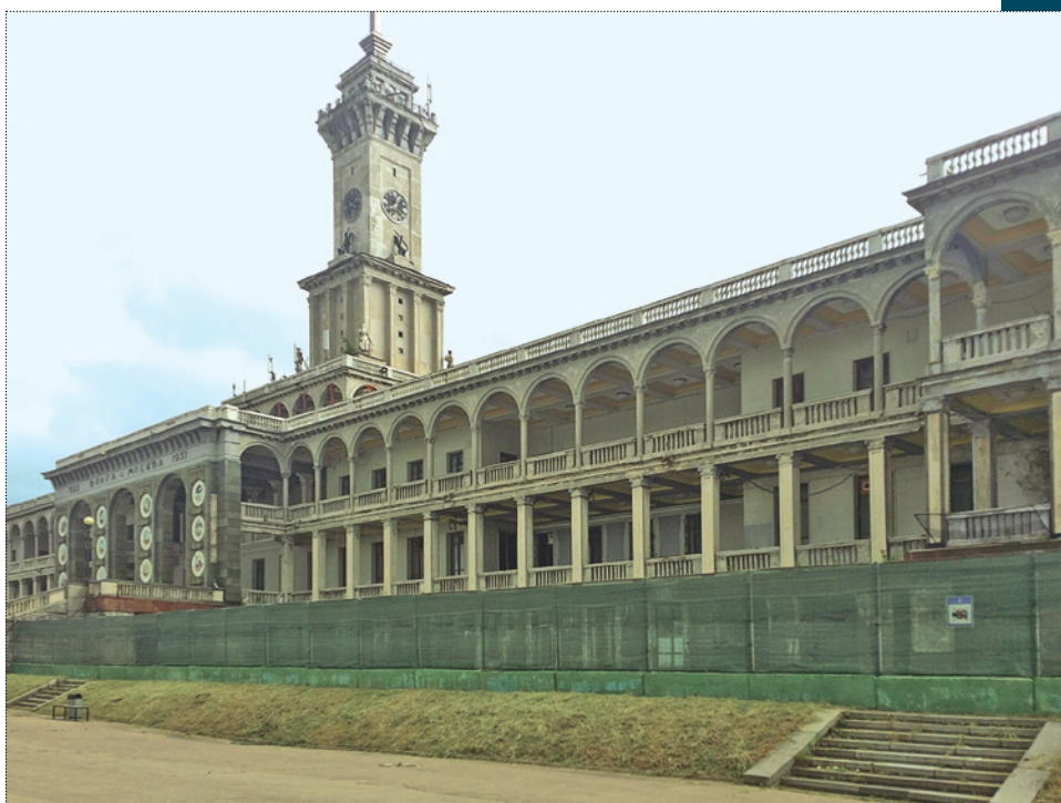
Главный фасад до реставрации. Фото 2017 года
