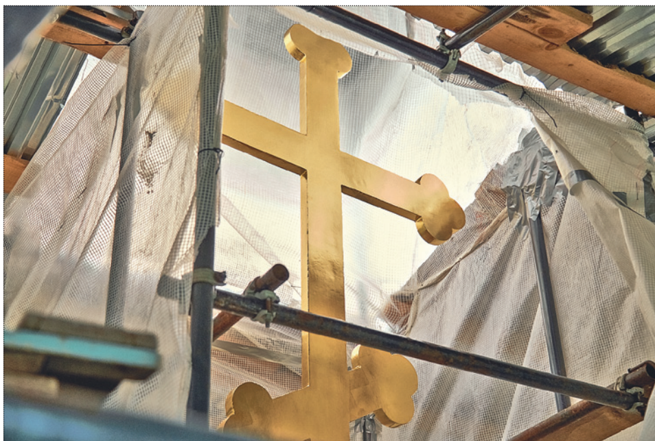
Установка креста на колокольне. Фото: Р.В. Ковальский, 2020 год
