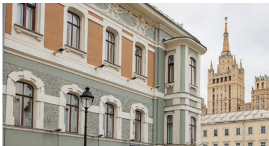
Фасад доходного дома Н.С. Кана со стороны М. Никитской улицы после реставрации. Фото А. Скворцов, 2021
