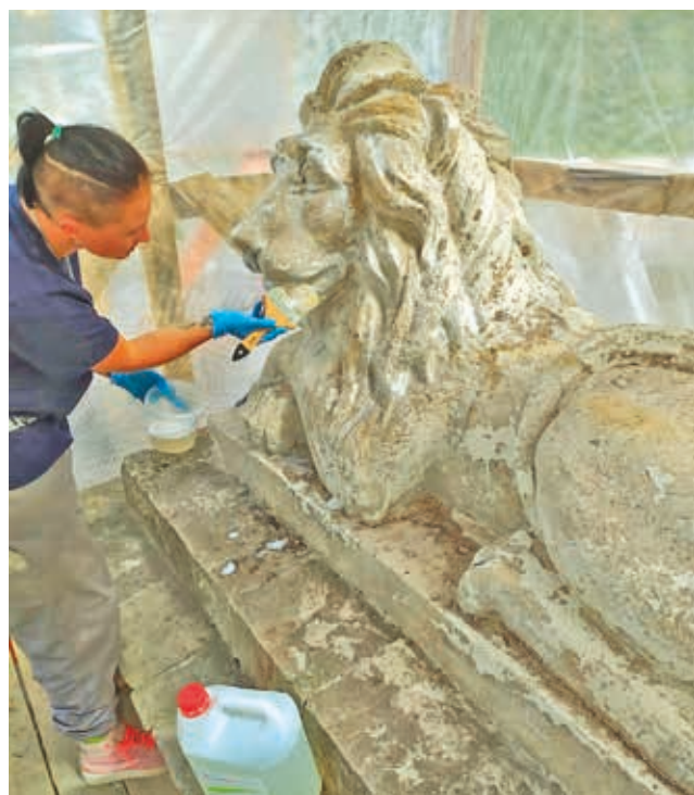
Скульптурные изображения львов. Лев справа. Промывка водой с использованием неионогенных моющих средств. Фото: Реставрационная мастерская «Наследие», 2021 год
