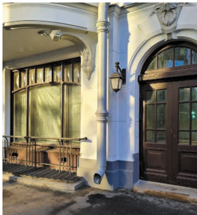
Восстановлено первоначальное состояние оконных стоярных заполнений бывшего магазина. Фото В. Кузнецов, 2021 год
