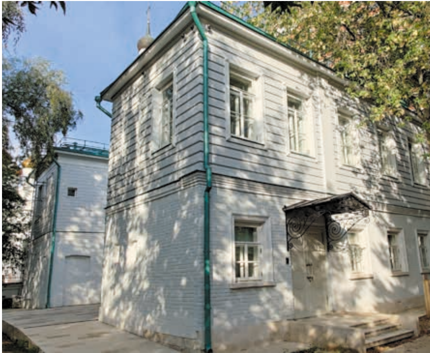
Фасады Дома Третьяковых после реставрации. Фото А. Скворцов, 2021 год
