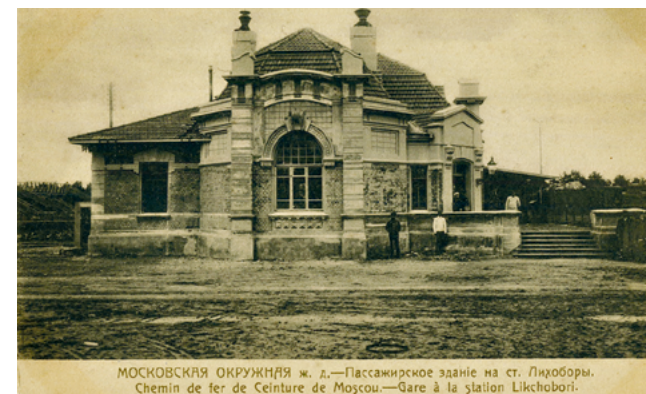
Пассажирское здание на станции Лихоборы
