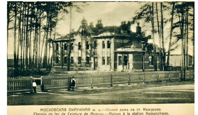
Жилой дом на станции Кожухово
