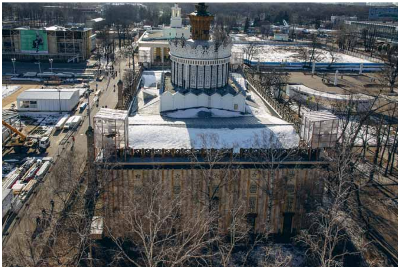
Вид павильона «Земледелие» с крыши павильона «Зерно» Фото В.М. Покачалова. 2017
