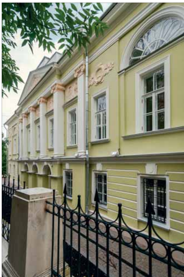
Петроверигский переулок, 4. Городская усадьба Боткиных – объект культурного наследия федерального значения. Фото: Департамент культурного наследия города Москвы, 2016 год
